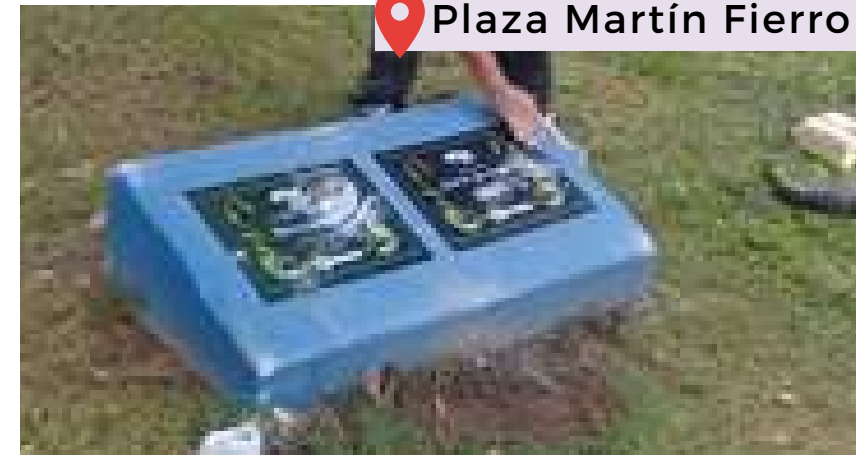
Colocación de placa
