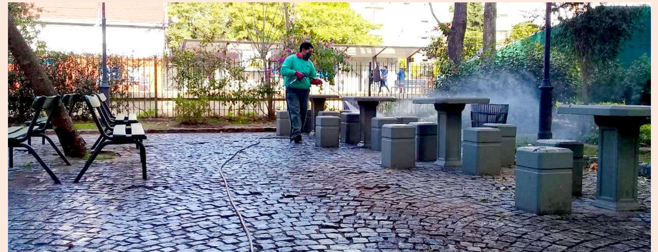
▲ Hidrolavado (Mobiliario Plaza Favaloro )
