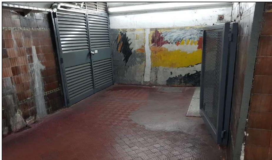
Foto nivel andén – Arranque E.M. N°19
