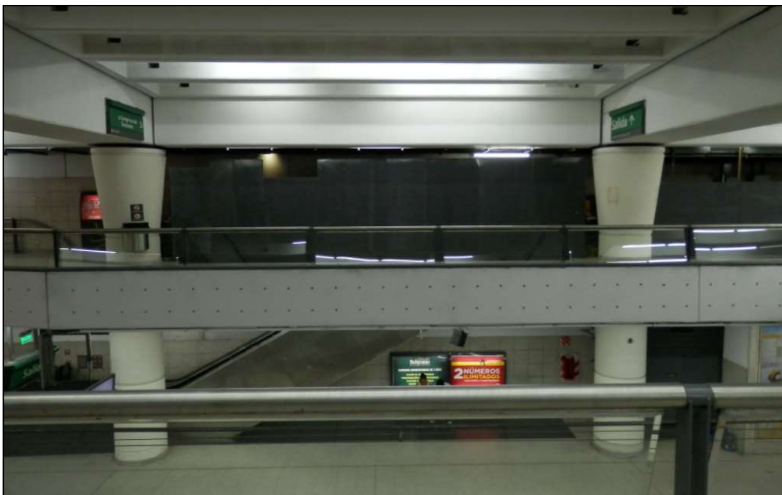
Foto nivel vestíbulo – Llegada escalera N°32 (confinada).
