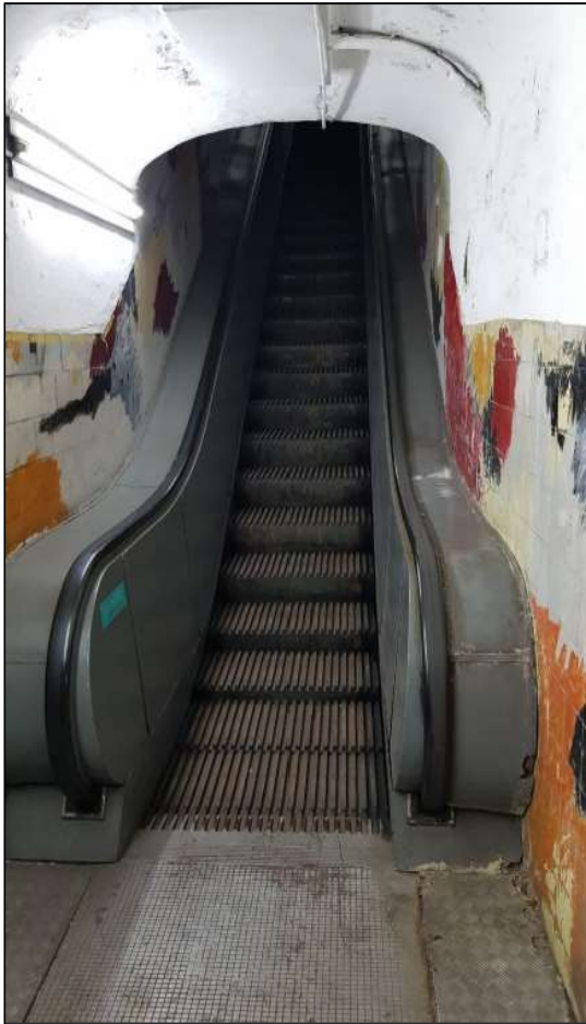
Foto nivel andén – Arranque E.M. N°20
