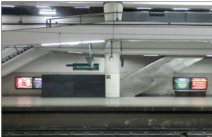
Foto nivel andén – Arranque escalera N°32 (confinada).
