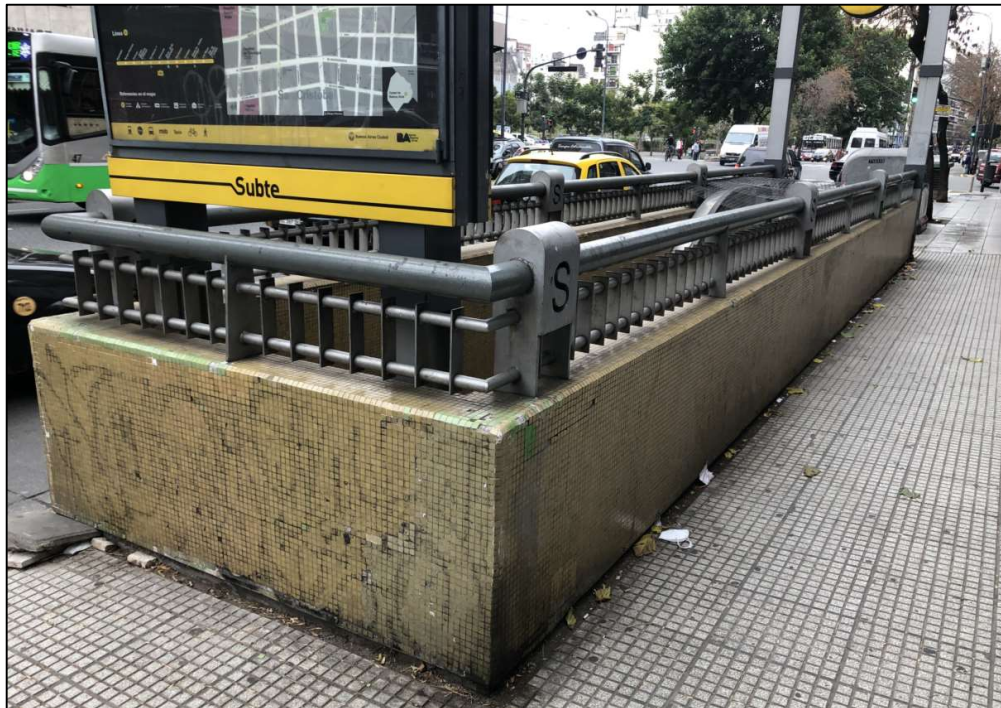
Fotos nivel calzada – Llegada E.M. N°2
