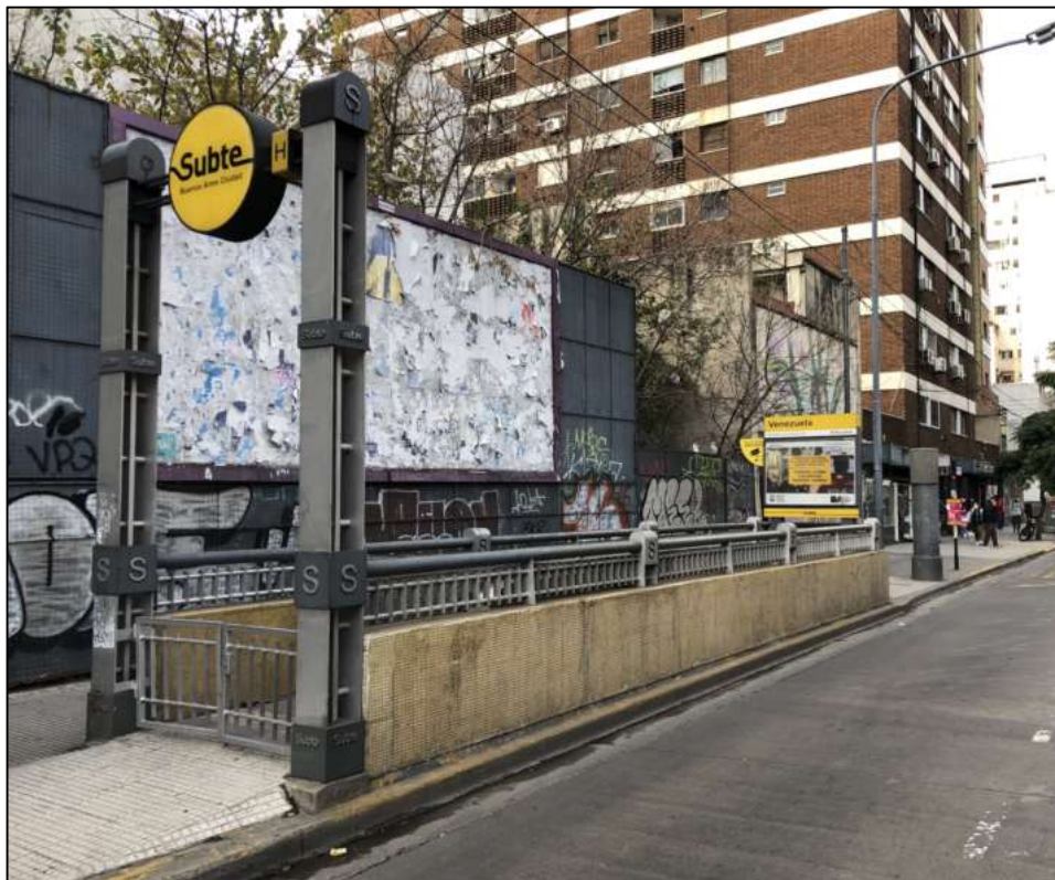
Fotos nivel calzada – Llegada E.M. N°2
