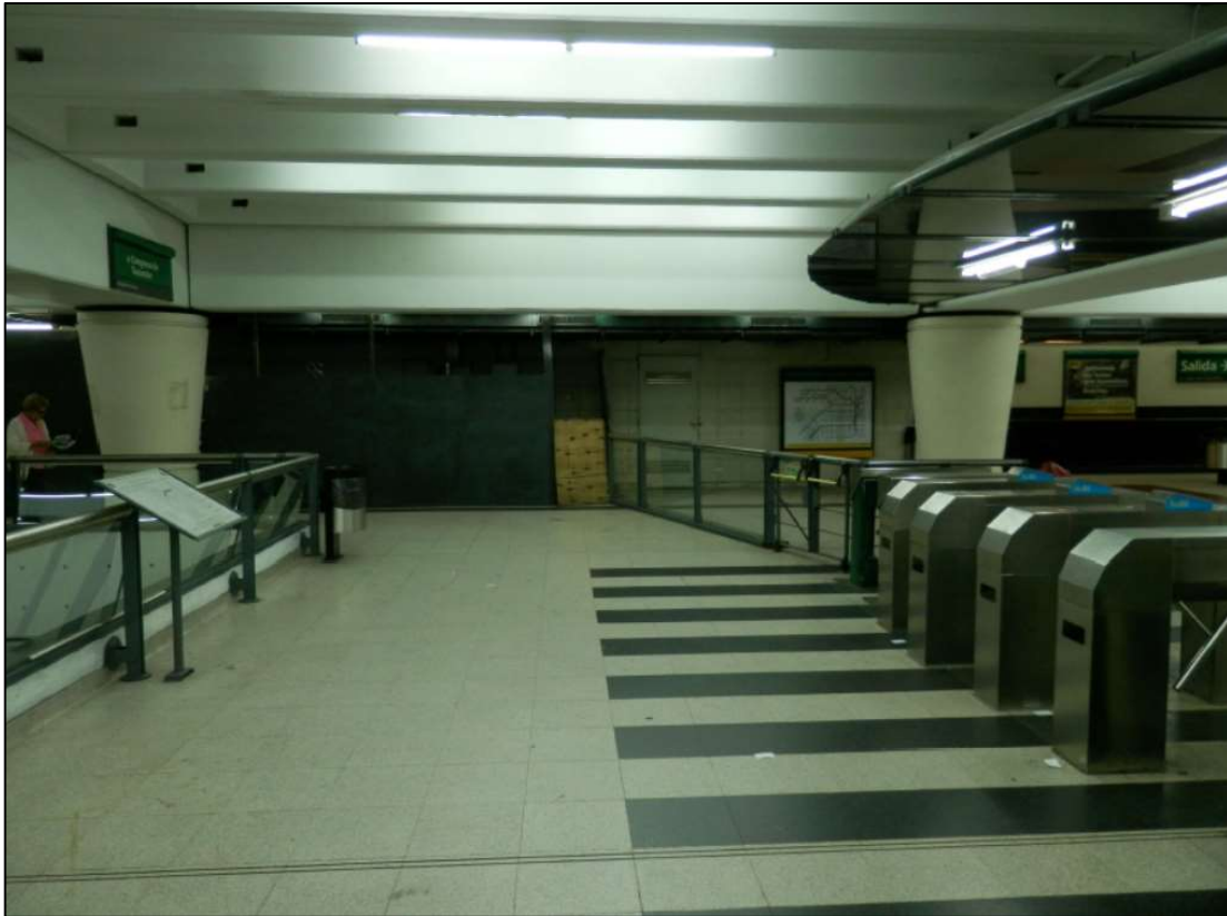
Foto nivel vestíbulo – Llegada de escalera N°32 - Foto desde línea de molinetes.
