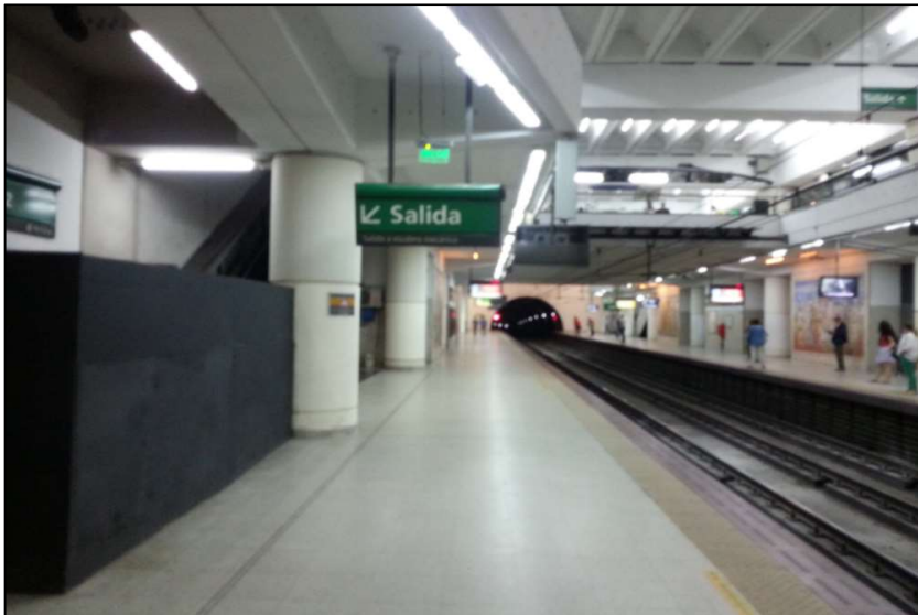
Foto nivel andén – Arranque escalera N°32 (confinada).
