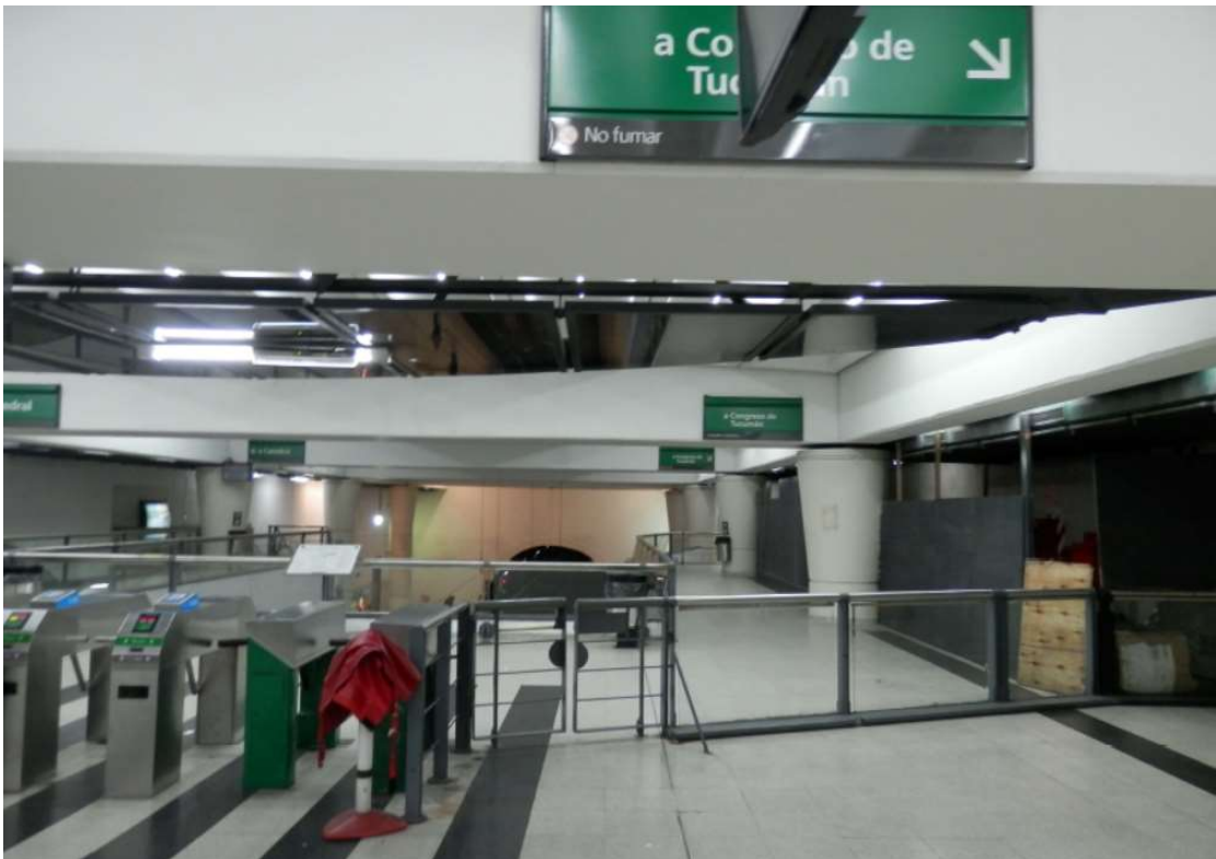
Foto nivel Vestíbulo – Llegada escalera N°32 (confinada).
