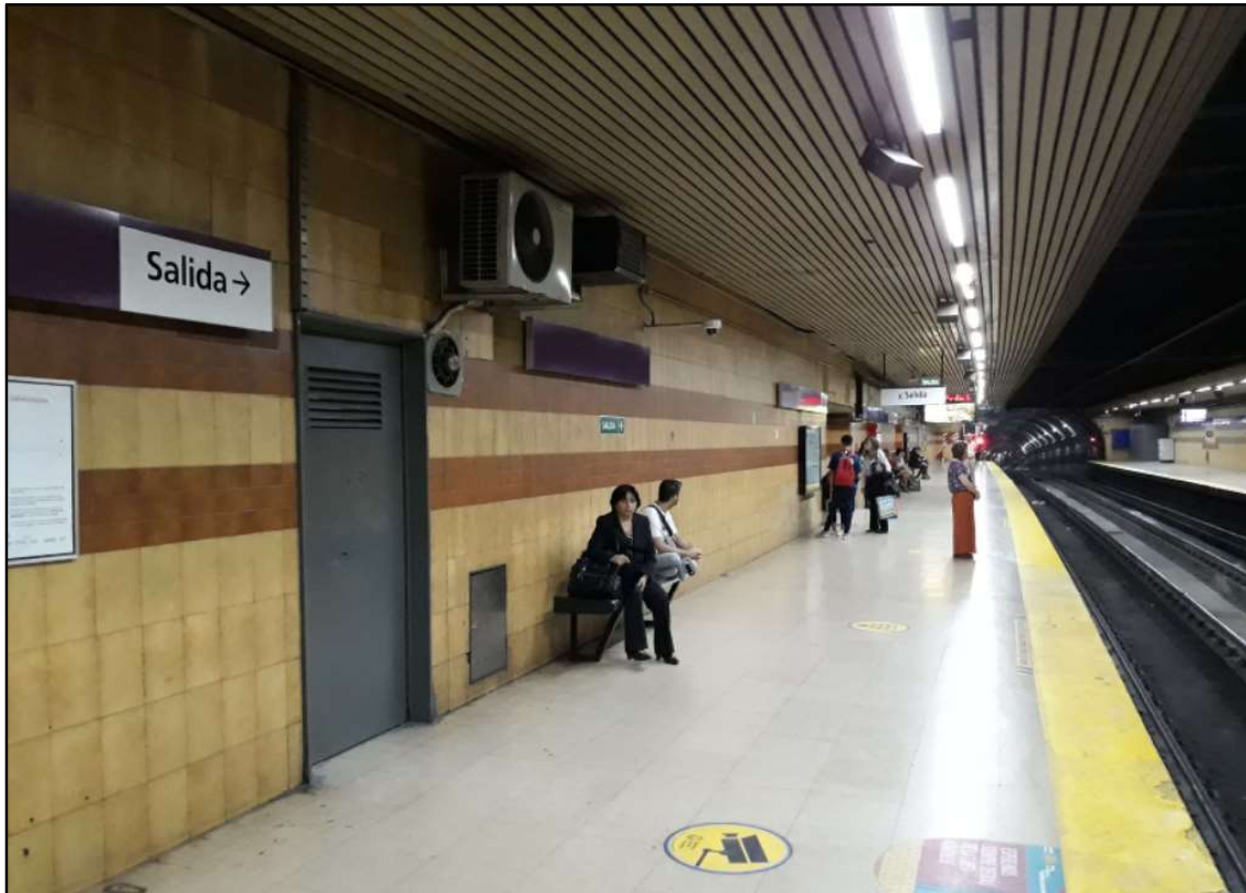
Foto nivel andén (Sur).
