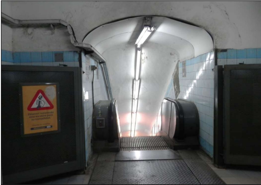
Foto nivel vestíbulo - Llegada E.M. N°4
