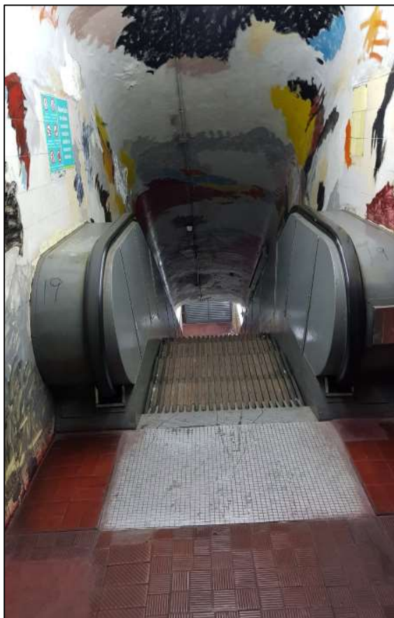
Foto nivel vestíbulo. Llegada E.M. N°20
