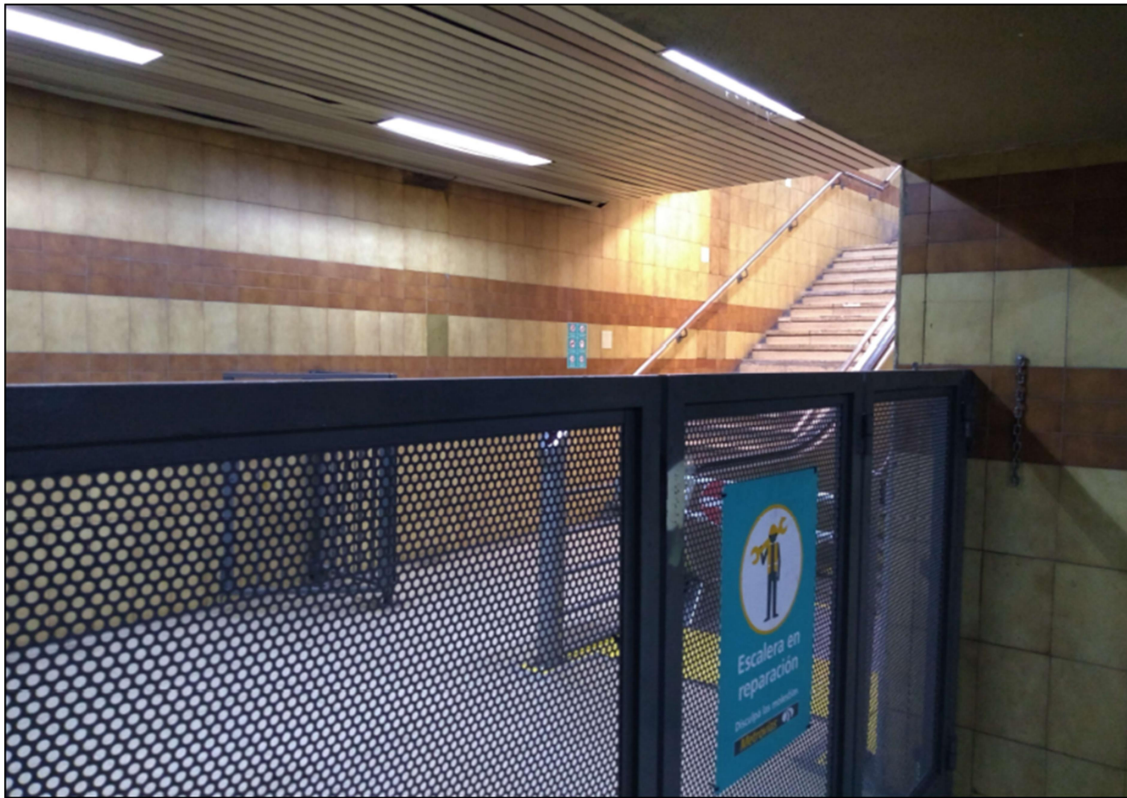
Foto nivel andén – Arranque de la E.M. N°26.
