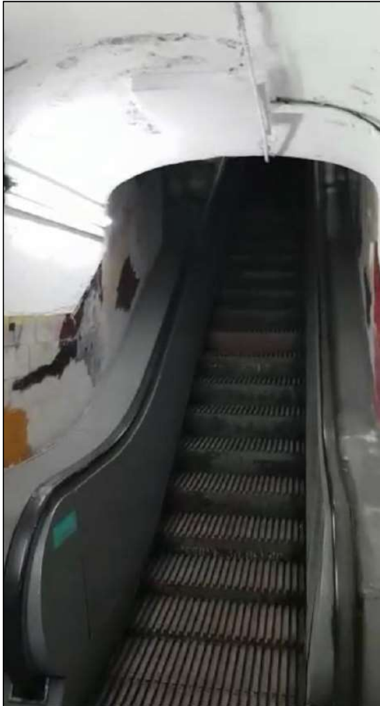
Foto nivel andén - Arranque E.M. N°19
