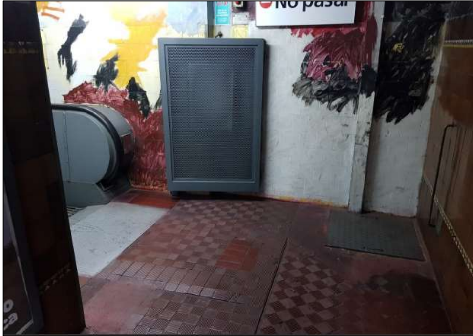
Foto nivel vestíbulo. Llegada E.M. N°19
