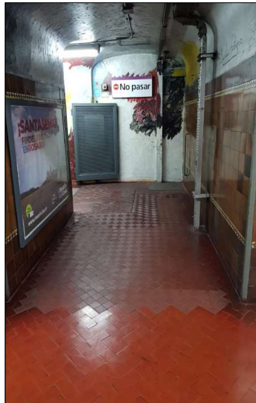
Foto nivel vestíbulo - Llegada E.M. N°19
