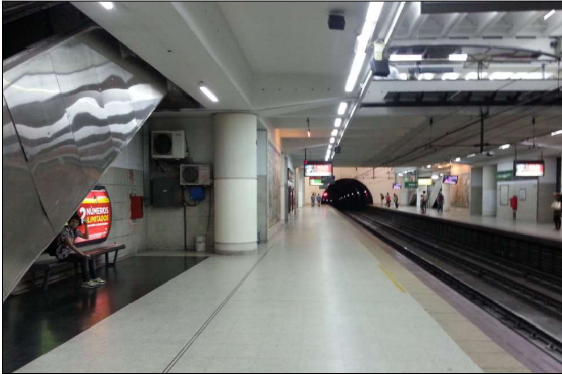
Foto nivel andén – Arranque Escalera N°32.
