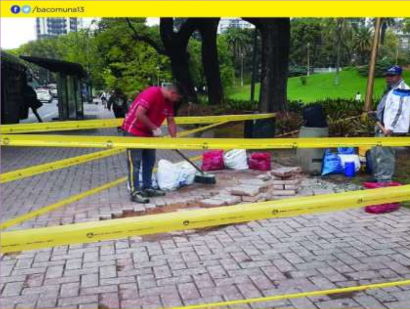
Reparación de intertrabado hundido entorno Barrancas de Belgrano.
