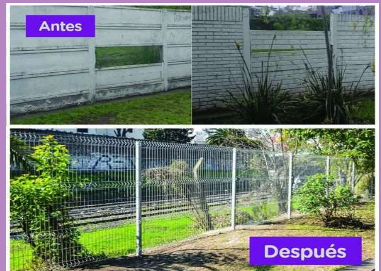
Plaza Proximidad Reconfiguración de límite con FFCC. Nuevo muro perimetral.
