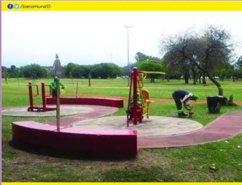
Pintura de mobiliario urbano en Plaza San Benito. Bancos y postas aeróbicas.
