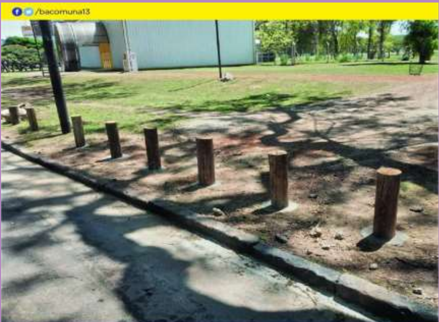
Colocación de tocones perimetrales en Plaza San Benito.
