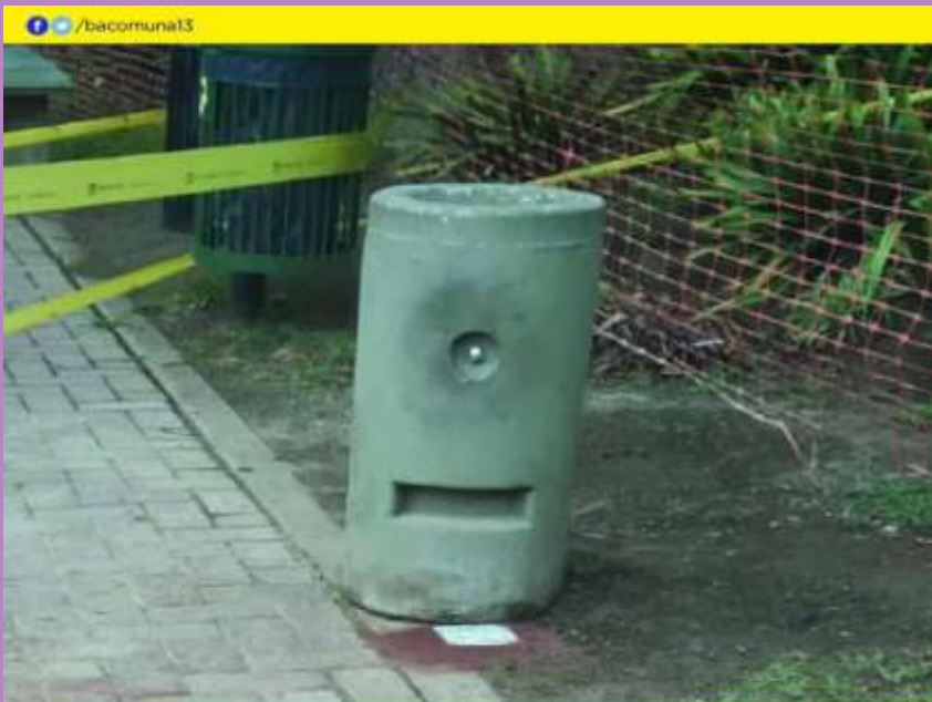
Reparación de bebedero Virrey Vértiz y Echevería.
