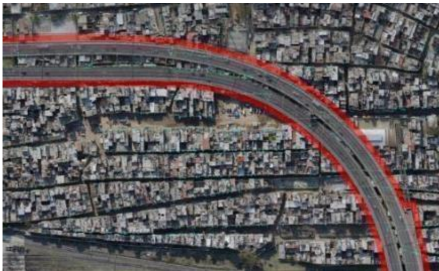
Imagen 11. Contorno de la afectación según CPU.
