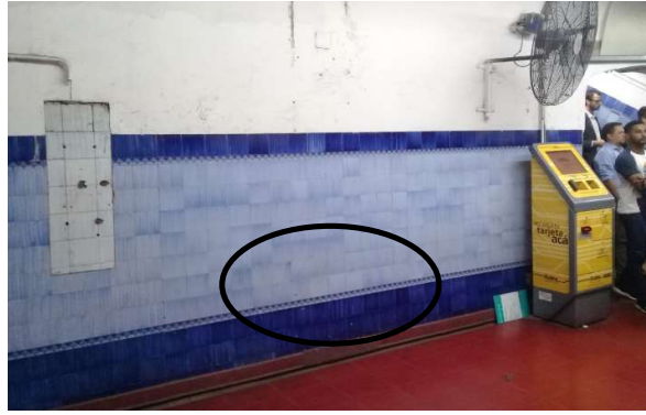
ESTACIÓN OLLEROS – ESPACIO 7
