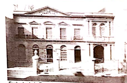
Fachada de la Escuela, ampliada hacia la derecha (AGN)
