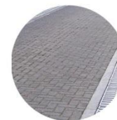
Solado intertrabado en Calle
