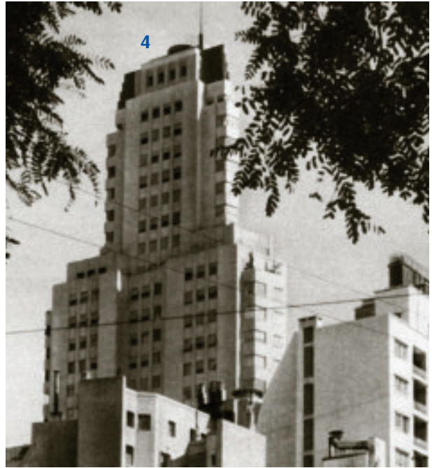
Remate del edificio Kavanagh. (DGPeIH)
