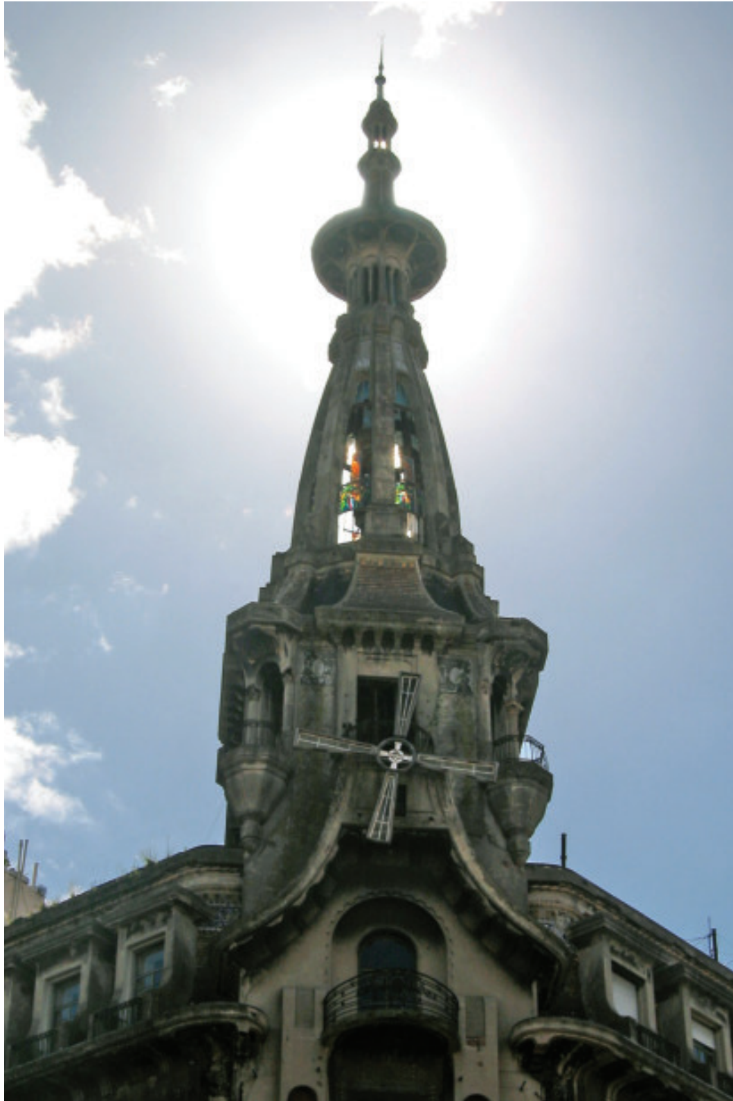
Cúpula ex Confitería del Molino. (DGPeIH)
