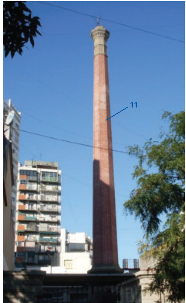
Caballito, ventilación de cloaca máxima. (NZ)
