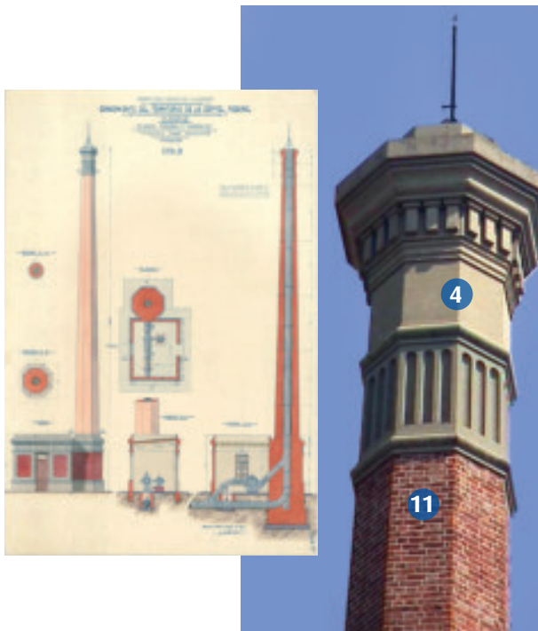
Ventilación de cloaca máxima. (DGPelH)
