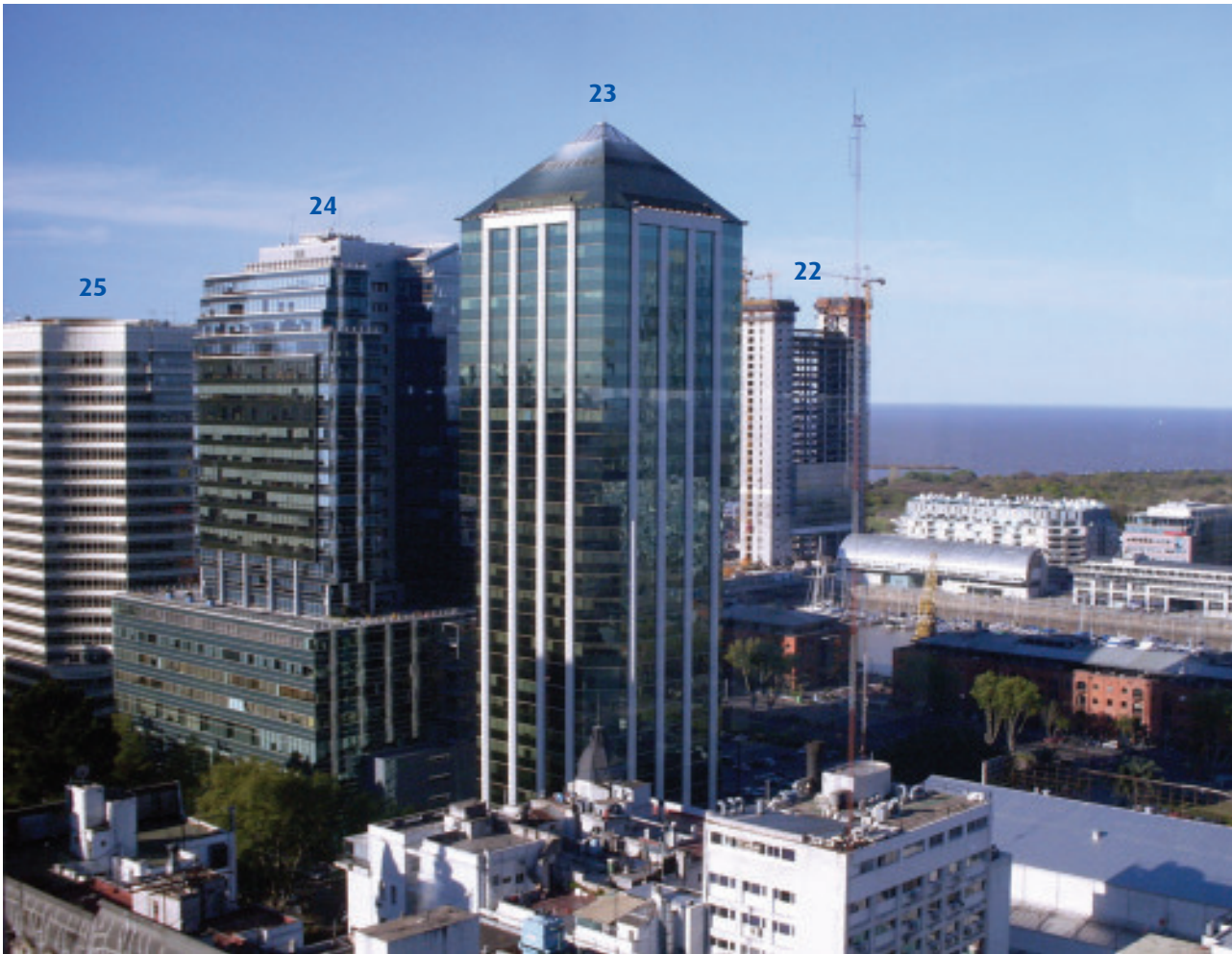
Vista noreste desde piso 19º del Edificio COMEGA. (SL)
