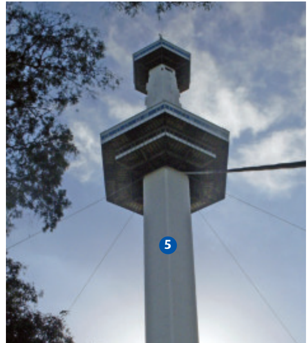
Torre Espacial, vista desde su base. (NZ)
