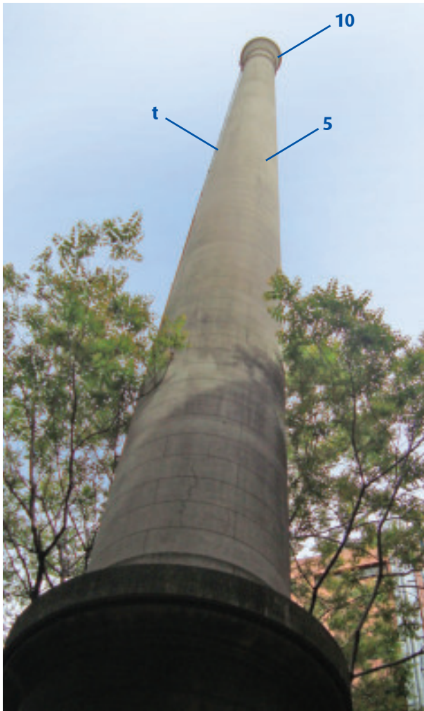
Barracas, ventilación de cloaca máxima. (NZ)
