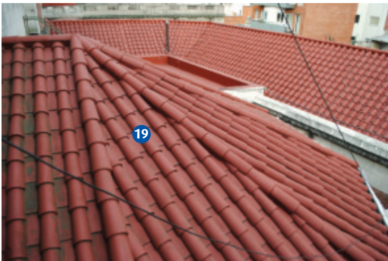
Cubierta interior de tejas. Patio. (FG)
