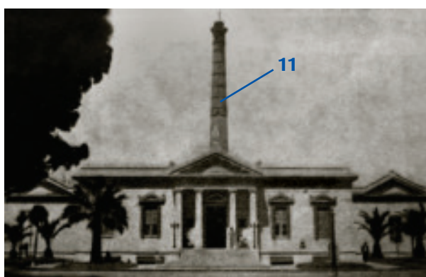
Crematorio con chimenea metálica. (LC)
