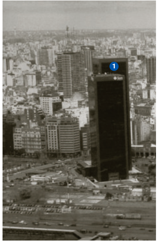
Torre Alem Plaza. (DGPelH)
