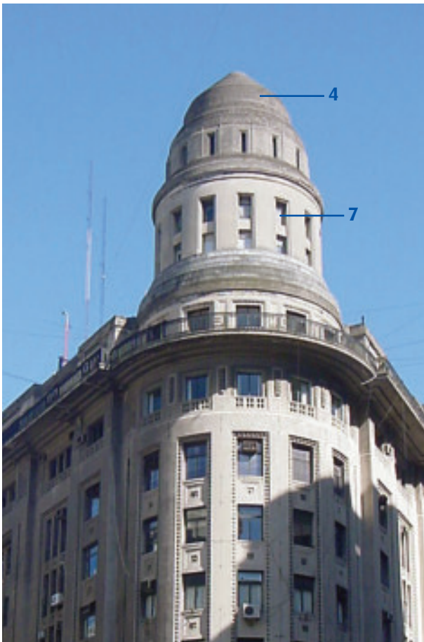
Edificio de la ex Equitativa del Plata. (SL)
