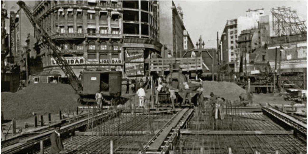
Obelisco en construcción. (DGPeIH)
