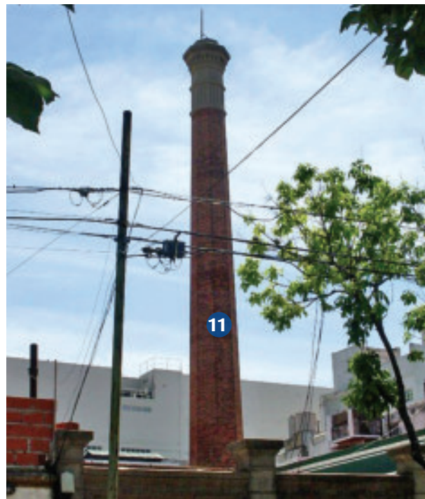
Boedo, ventilación de cloaca máxima. (NZ)
