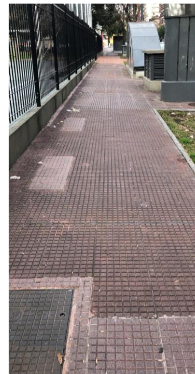
Reconstrucción de vereda F. Roosevelt
