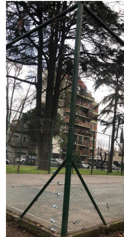
Reparación de alambrado en cancha de futbol
