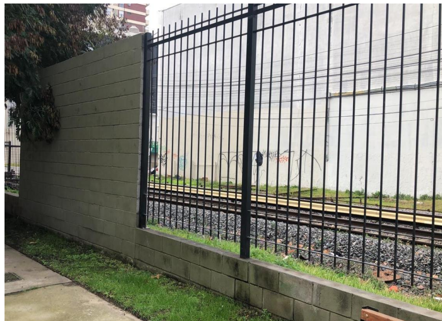
Reforma del muro perimetral por rejas
