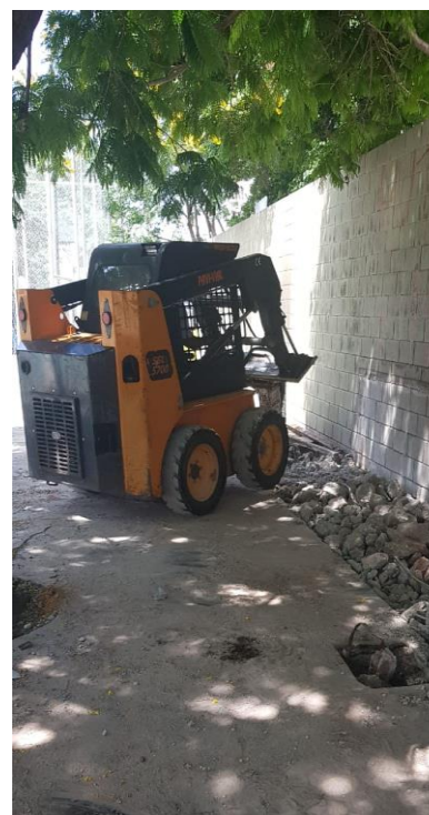
Demolición de gradas
