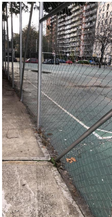
Reparación de alambrado en cancha de futbol
