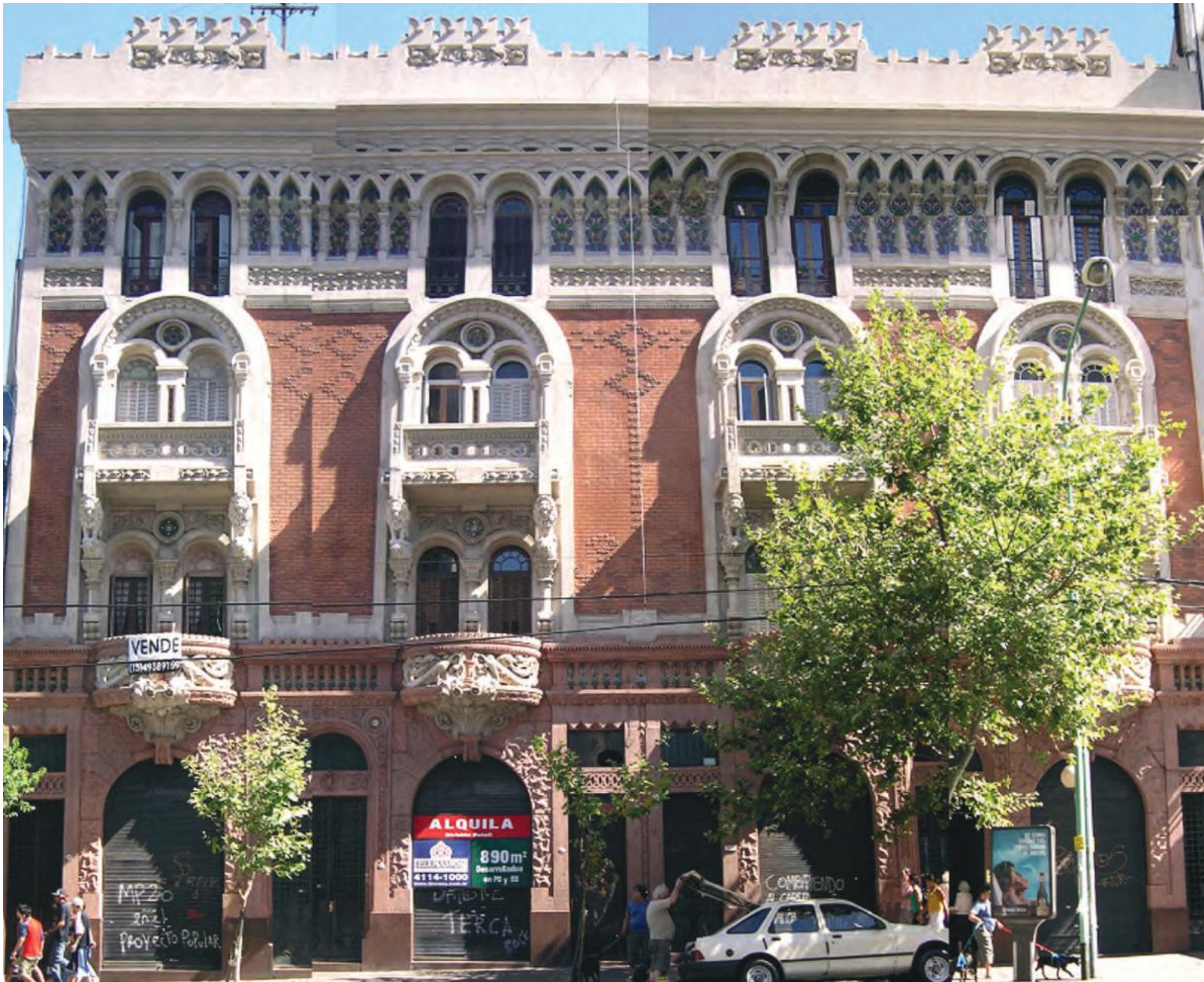
EDIFICIO AL FINALIZAR LAS OBRAS
