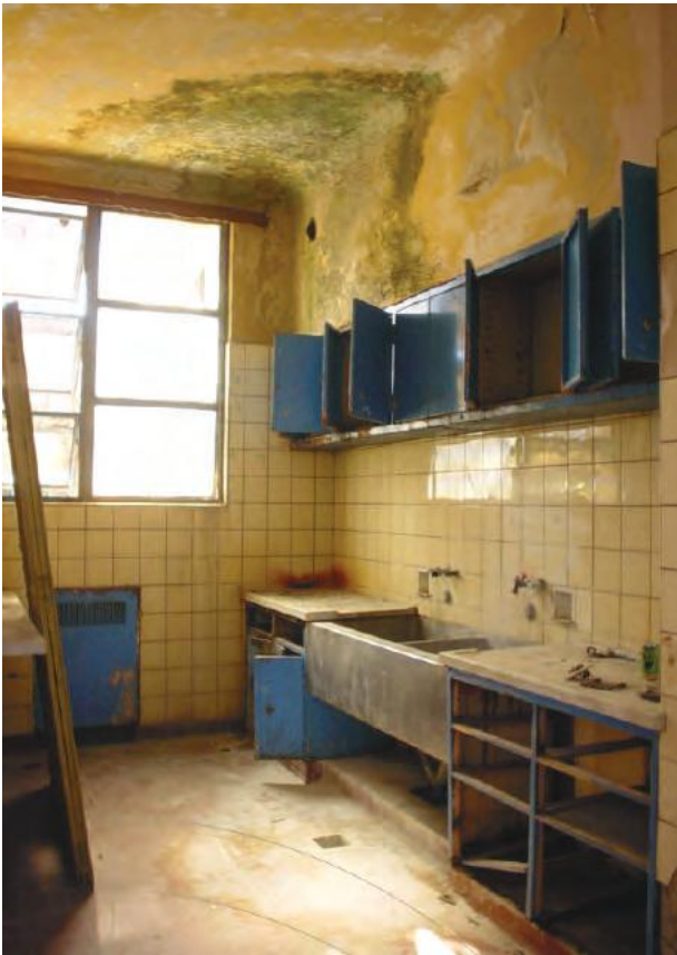
COCINA ANTES Y DESPUES DE LAS OBRAS
