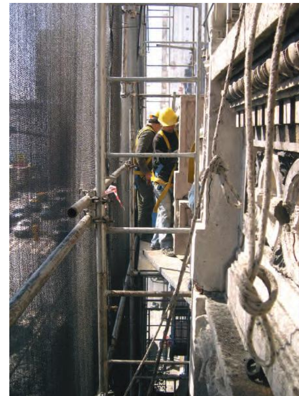
DURANTE LAS TAREAS DE RESTAURACIÓN
