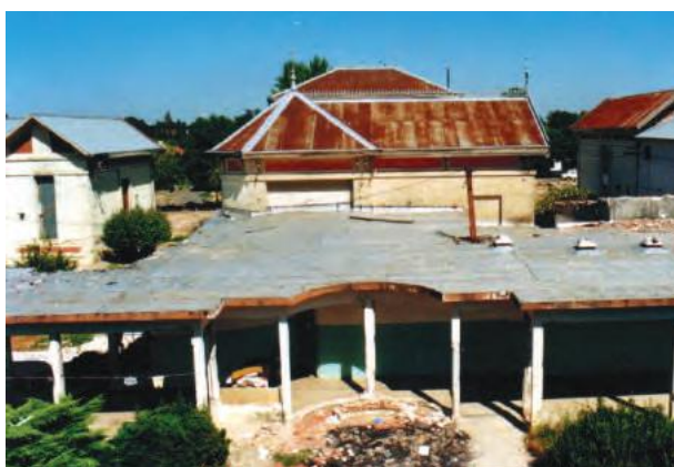
SITUACIÓN DE LA EDIFICACIÓN ANTES DE LAS OBRAS
