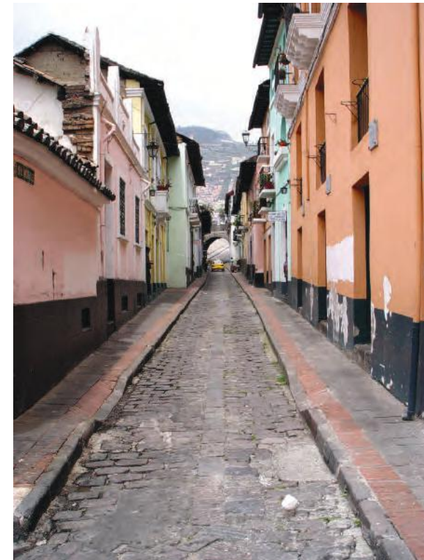
CALLE LA RONDA ANTES DE LA INTERVENCION
