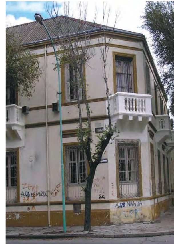
FACHADA DE UN SECTOR DEL COMPLEJO. BALCÓN RECUPERADO.
