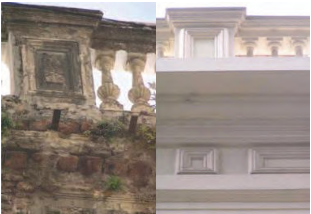
INTERVENIR PRESERVANDO Y RECUPERANDO
