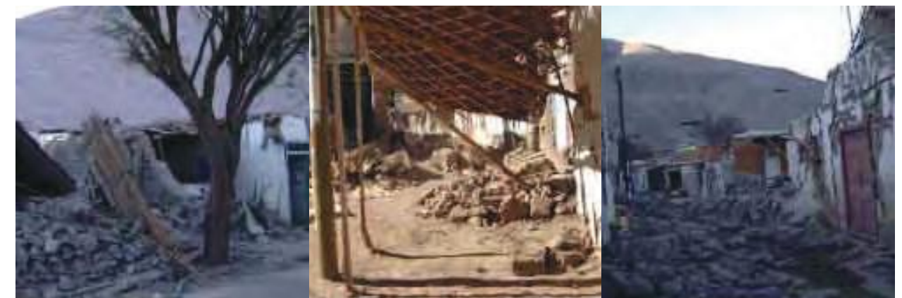
SITUACIÓN LUEGO DEL TERREMOTO DE 2005
