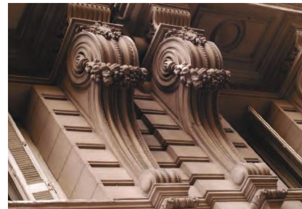
DETALLE DE FACHADA DE AVENIDA DE MAYO.
