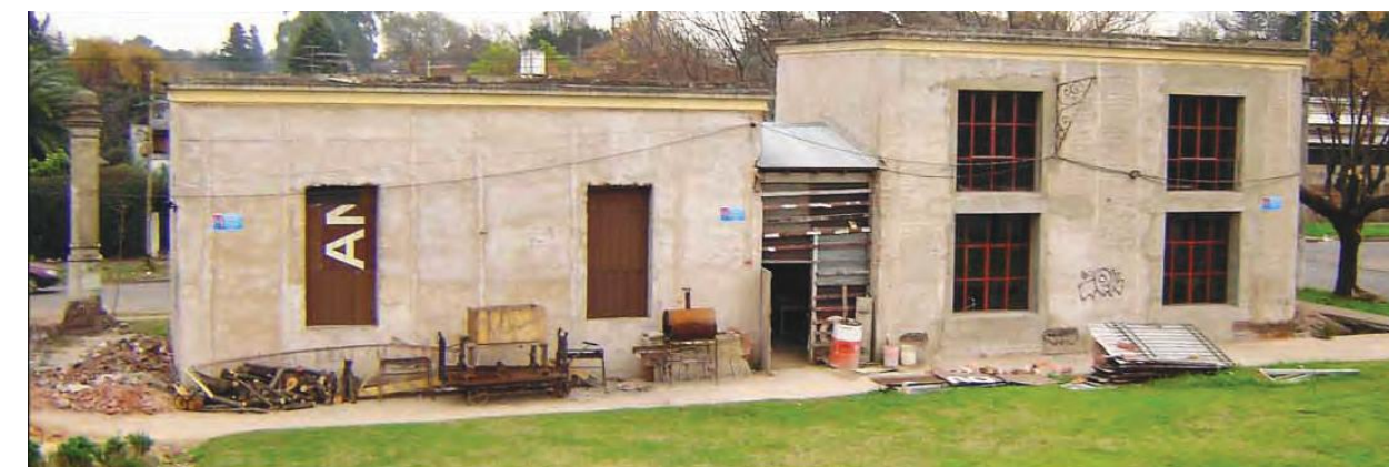
TRABAJOS DURANTE LA OBRA
