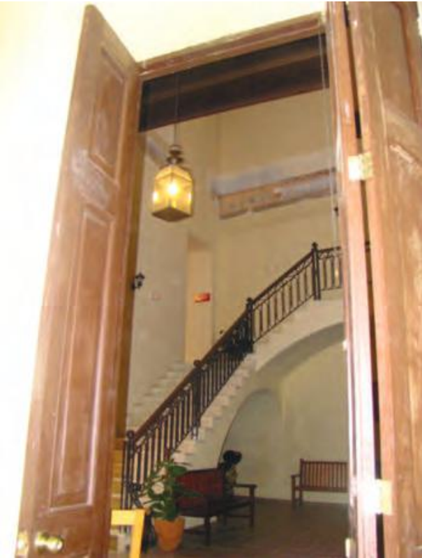
DIFERENTES IMÁGENES DEL EDIFICIO LUEGO DE LA INTERVENCIÓN.
