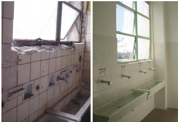
BAÑOS ANTES Y DESPUÉS DE LAS OBRAS
