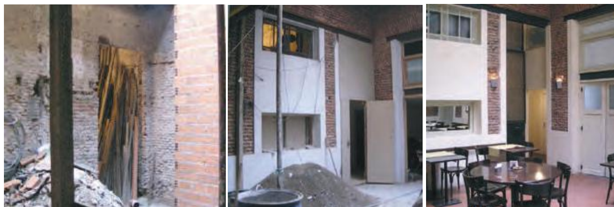
ETAPAS DE LA OBRA EN EL PATIO EN PLANTA BAJA.
