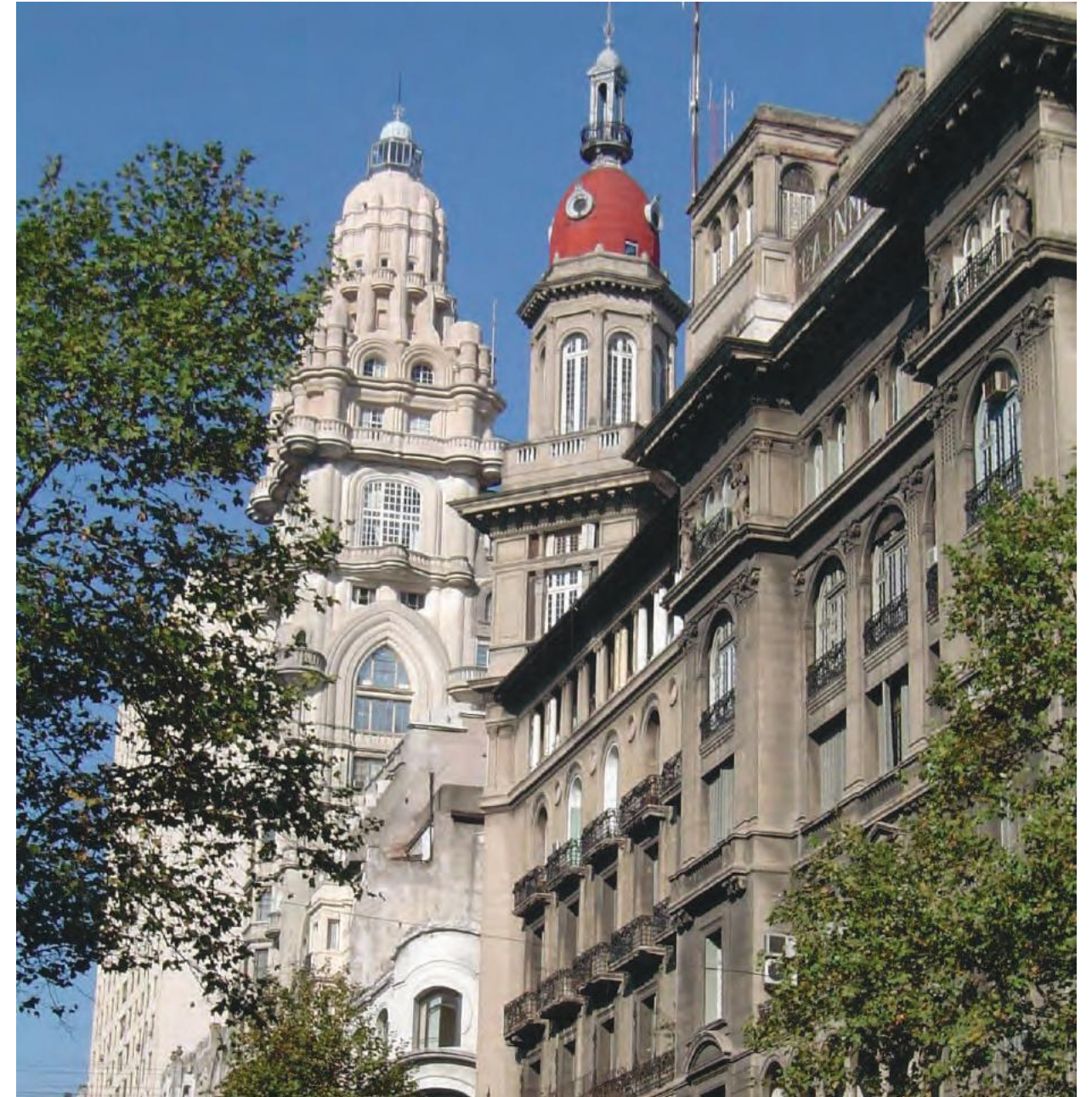
VISTA DE LOS EDIFICIOS LA INMOBILIARIA Y PALACIO BAROLO, CIUDAD AUTÓNOMA DE BUENOS AIRES
