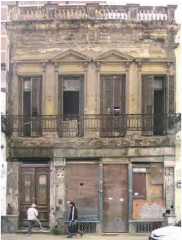
LA FACHADA ANTES Y DESPUÉS DE LAS OBRAS
