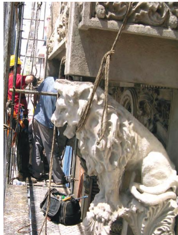
RESTAURACIÓN DE LA ORNAMENTACIÓN
