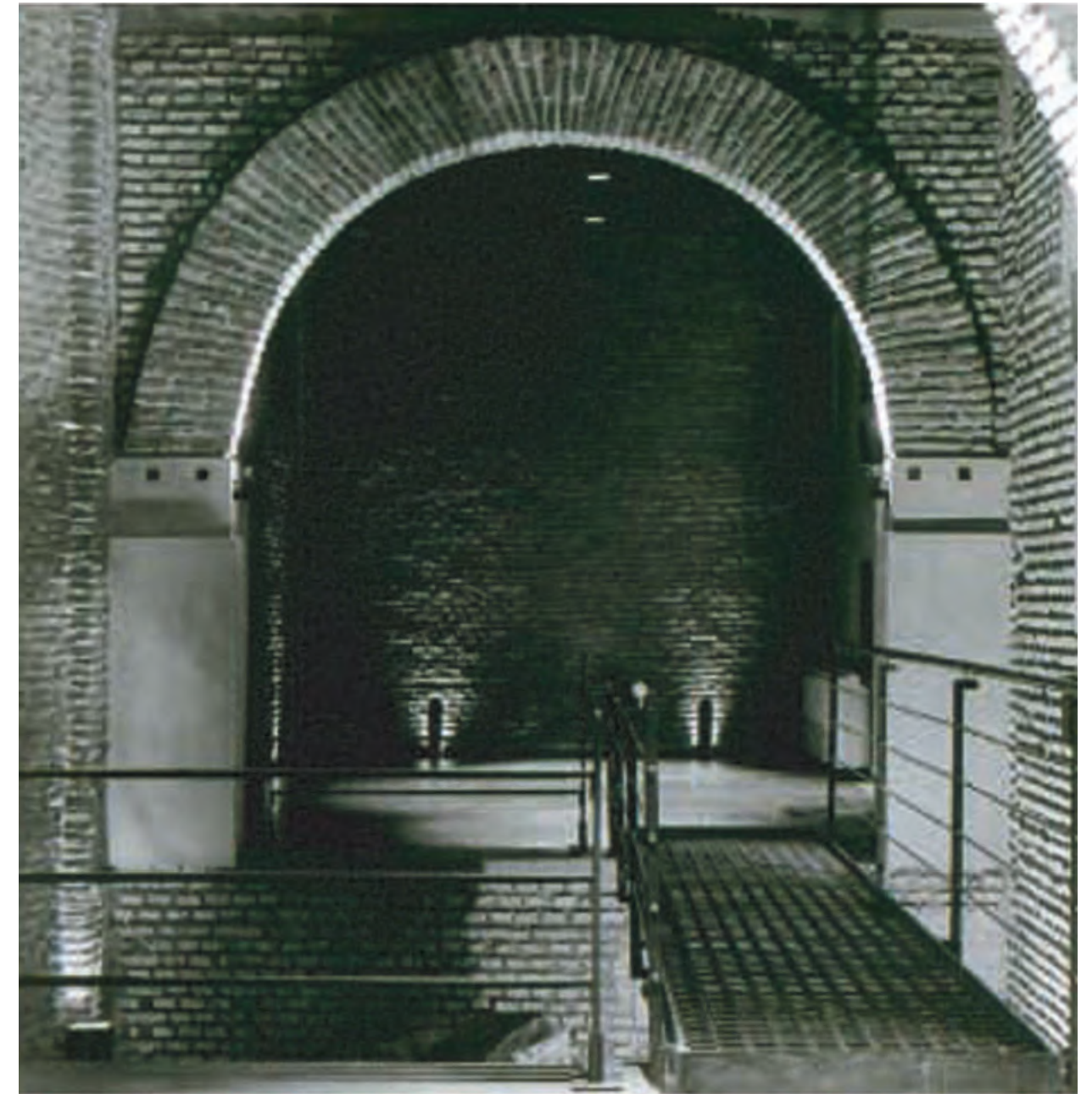
INTERIOR DEL EDIFICIO DE DEFENSA 751-755-759
