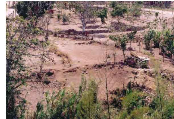
EXCAVACIONES EN EL LUGAR
