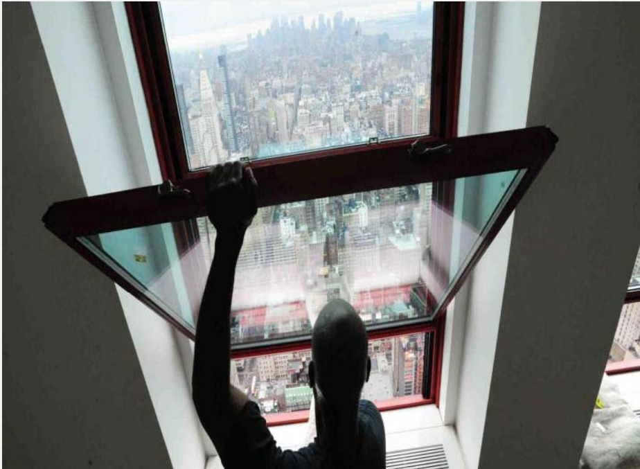
Cambio de carpinterías exteriores. Empire State Building. Nueva York.
