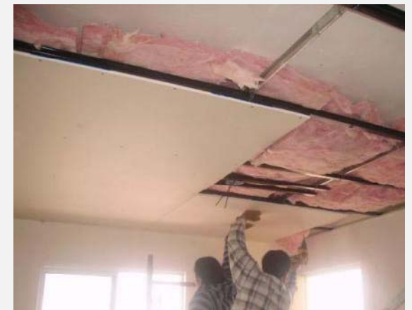
Aislamiento interior en techos
