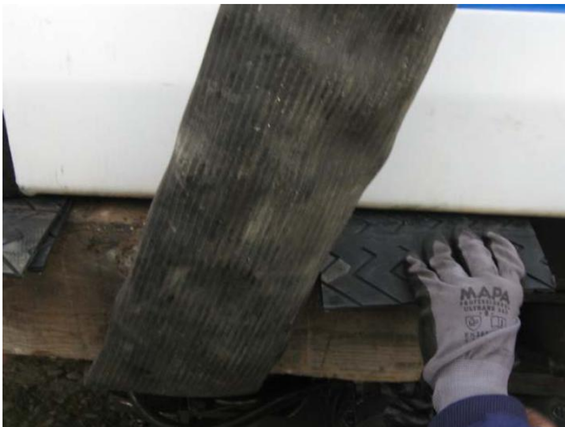
Imagen 9 – Vista del posicionamiento del taco de madera.
