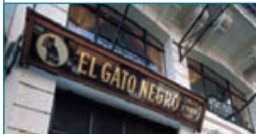
26 > EDIFICIO DE RENTA / BAR "EL GATO NEGRO"
