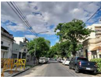
FOTO - CORREDOR ANTES
