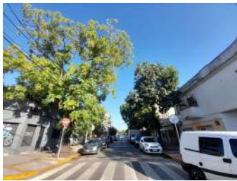
FOTO - CORREDOR ANTES
