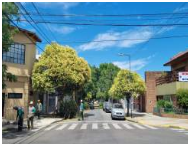
FOTO - CORREDOR DESPUES
