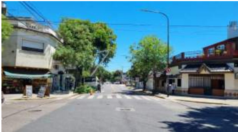
FOTO - CORREDOR DESPUES
