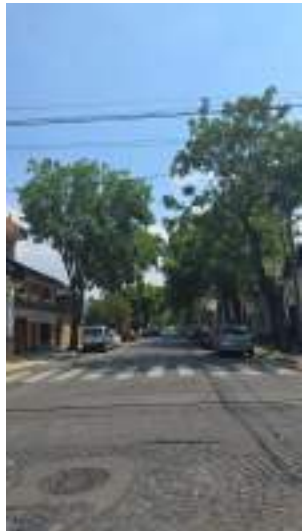
FOTO - CORREDOR DESPUES
