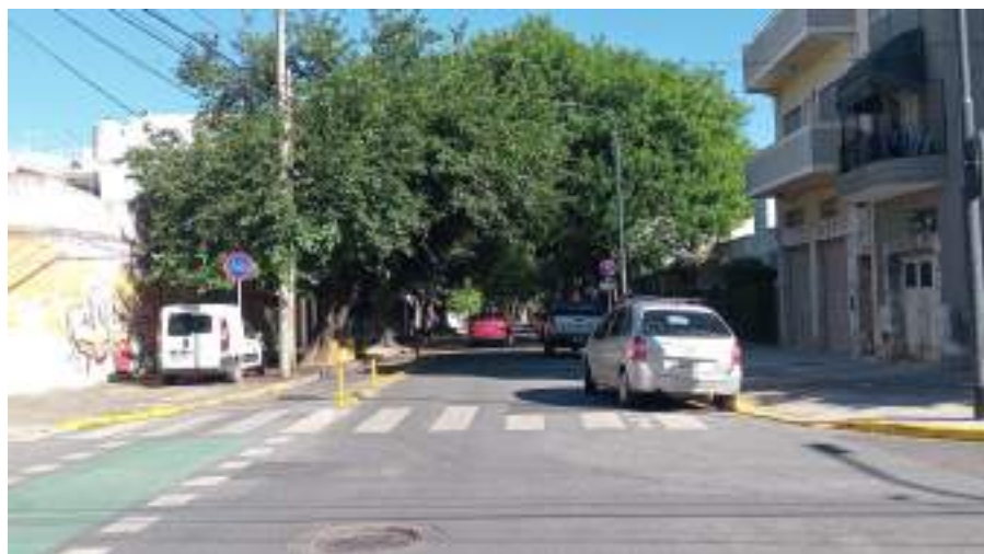
FOTO - CORREDOR ANTES
