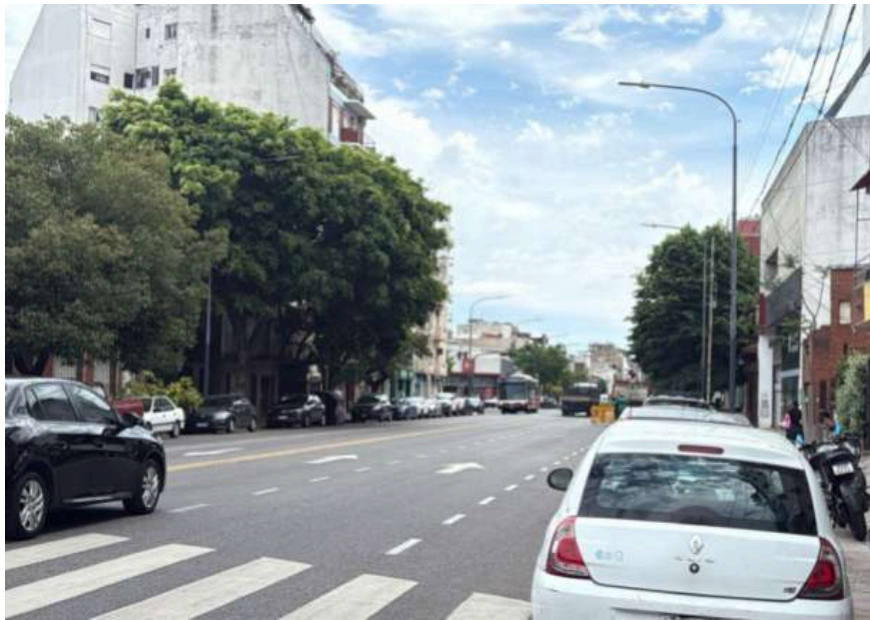
FOTO - CORREDOR ANTES
