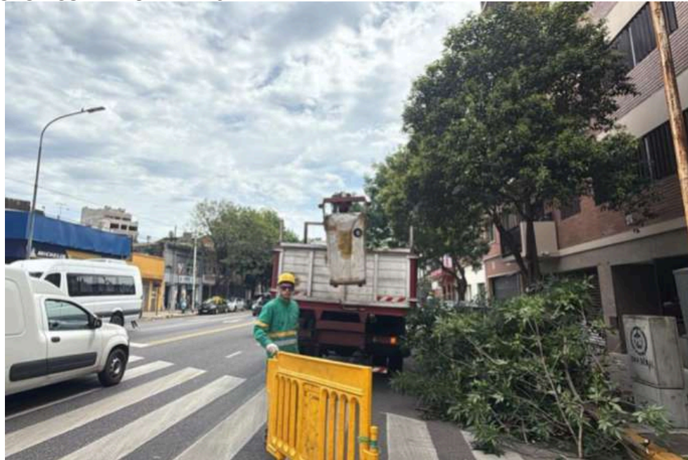
FOTO - CORREDOR ANTES
