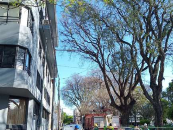
FOTO - CORREDOR ANTES
