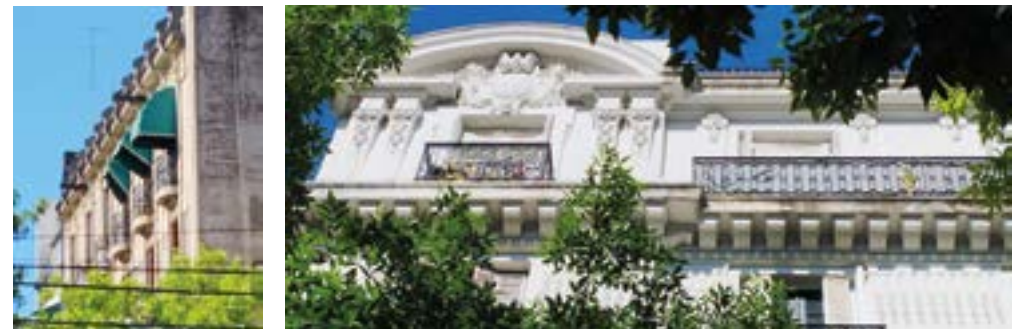
Edificios de viviendas. Pichincha 192 y 364, CABA.
