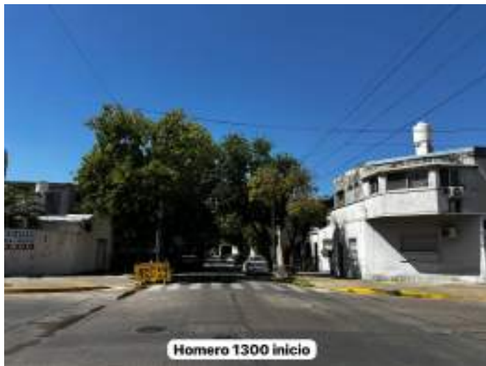
FOTO - CORREDOR ANTES
