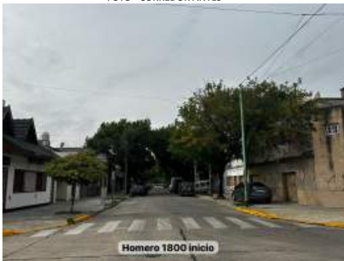
FOTO - CORREDOR ANTES
