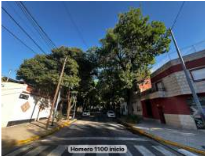
FOTO - CORREDOR ANTES
