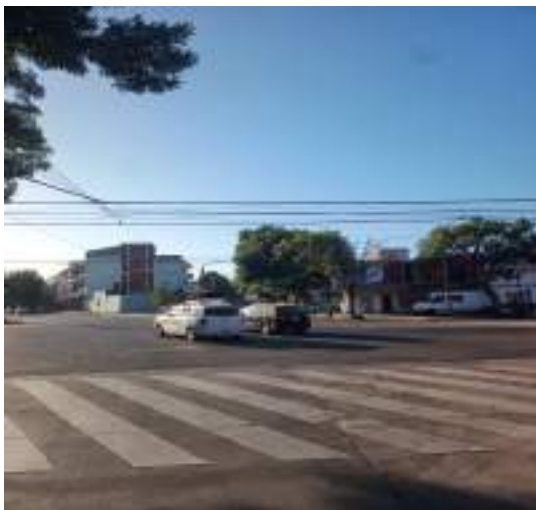
FOTO - CORREDOR ANTES
