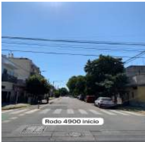
FOTO - CORREDOR ANTES
