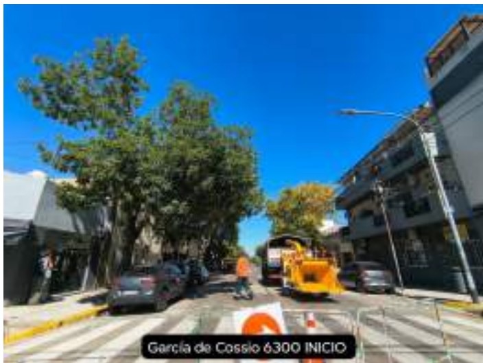
FOTO - CORREDOR ANTES
