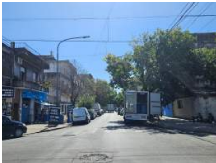
FOTO - CORREDOR ANTES
