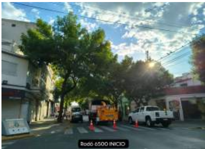
FOTO - CORREDOR ANTES
