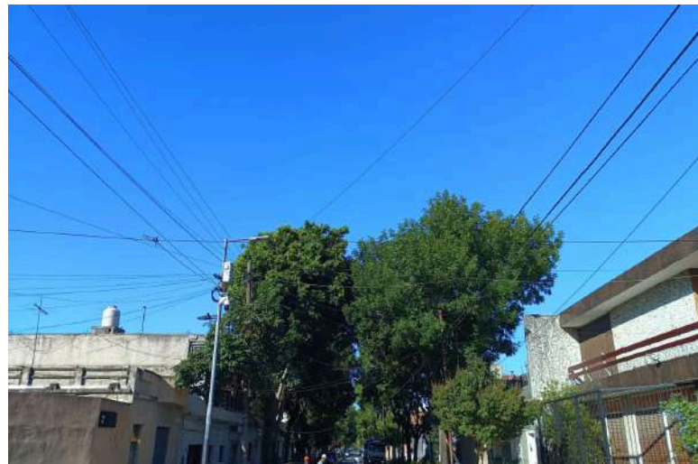
FOTO - CORREDOR DESPUÉS
