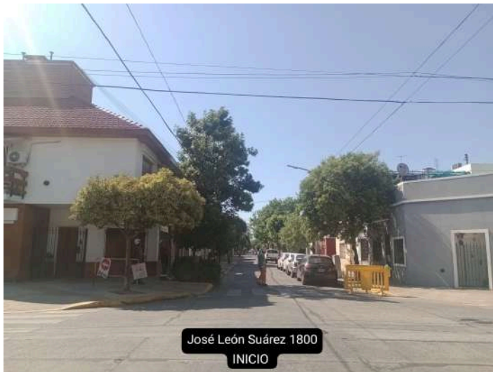
FOTO - CORREDOR ANTES
