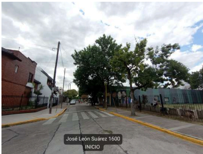
FOTO - CORREDOR ANTES
