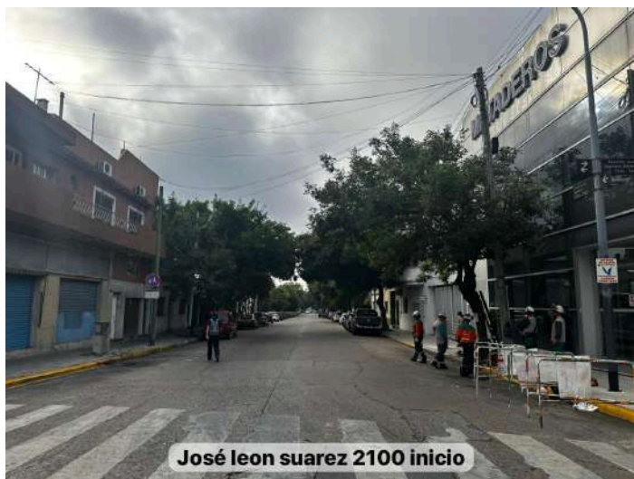
FOTO - CORREDOR ANTES
