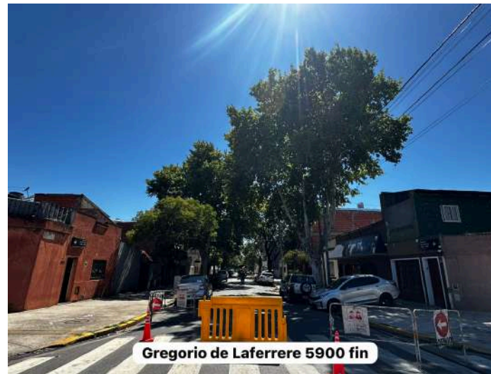
FOTO - CORREDOR DESPUÉS
