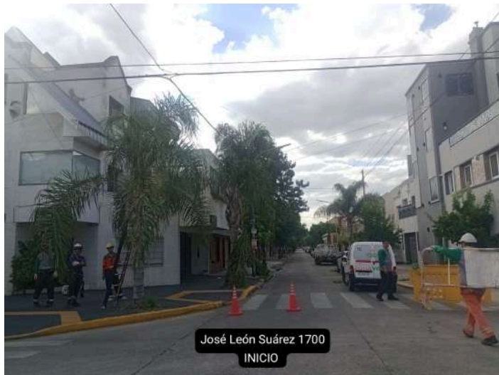
FOTO - CORREDOR ANTES
