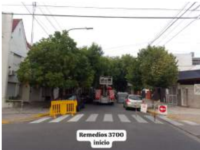
FOTO - CORREDOR ANTES
