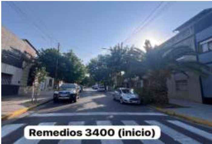
FOTO - CORREDOR ANTES
