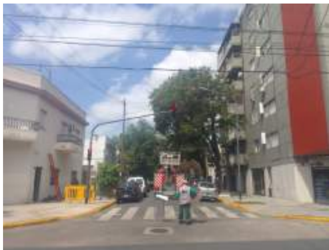
FOTO - CORREDOR ANTES
