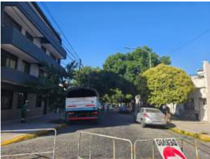
FOTO - CORREDOR ANTES
