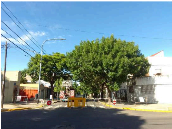
FOTO - CORREDOR ANTES
