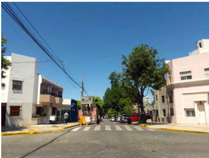
FOTO - CORREDOR ANTES
