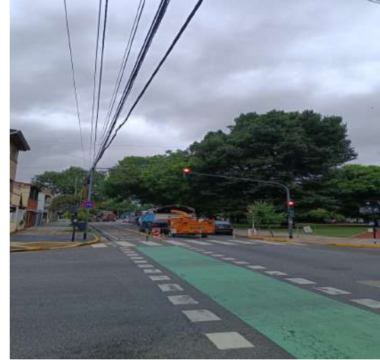
FOTO - CORREDOR DESPUÉS
