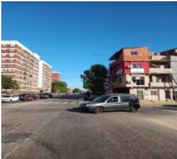
FOTO - CORREDOR ANTES
