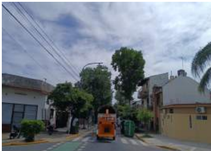
FOTO - CORREDOR ANTES
