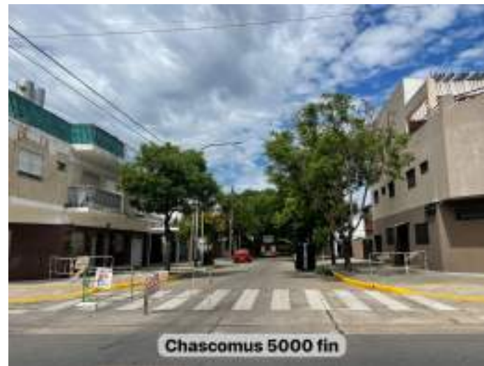
FOTO - CORREDOR DESPUÉS
