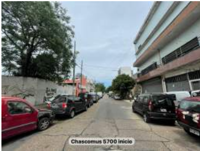
FOTO - CORREDOR ANTES
