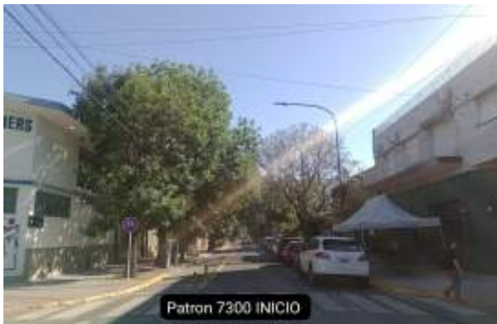
FOTO - CORREDOR ANTES
