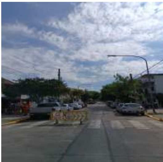
FOTO - CORREDOR ANTES
