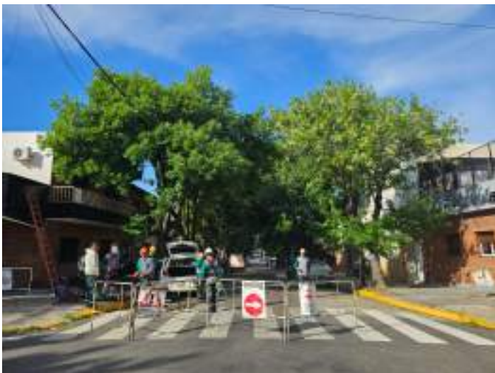
FOTO - CORREDOR ANTES
