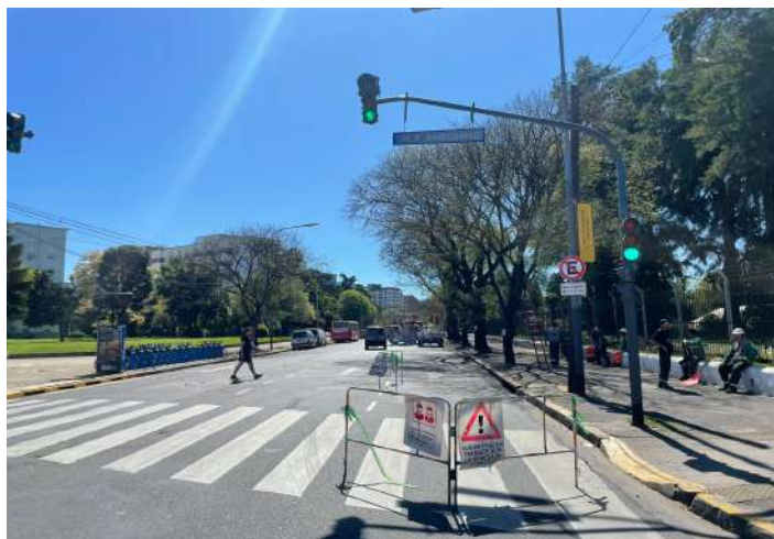
FOTO - CORREDOR ANTES
