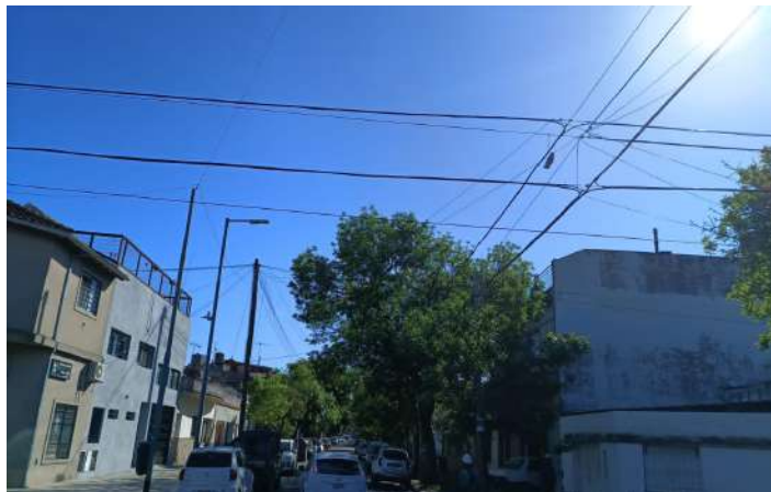
FOTO - CORREDOR ANTES
