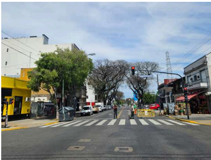
FOTO - CORREDOR ANTES
