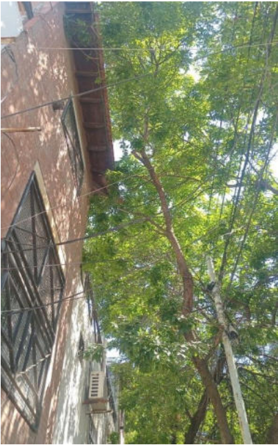
ANTES DESPEJE DE TECHOS
