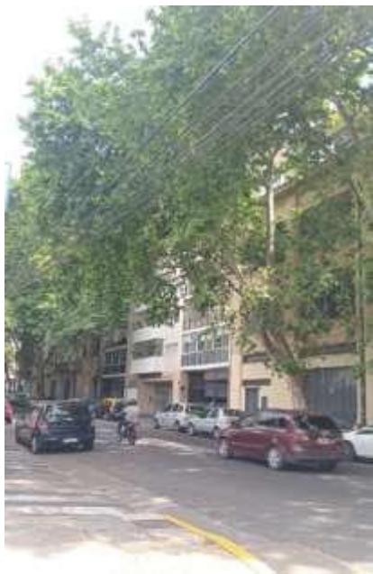
FOTO - CORREDOR ANTES
