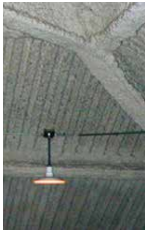
Estructuras metálicas: Asbesto proyectado
