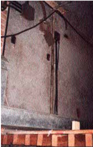
Asbesto proyectado sobre vigas, paredes y cielorrasos
