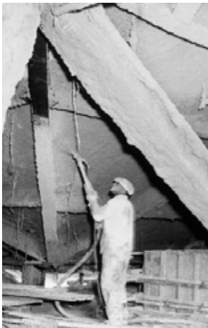
Estructuras metálicas: Asbesto proyectado
