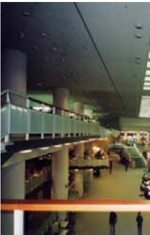
Placas acústicas en paredes y cielorrasos
