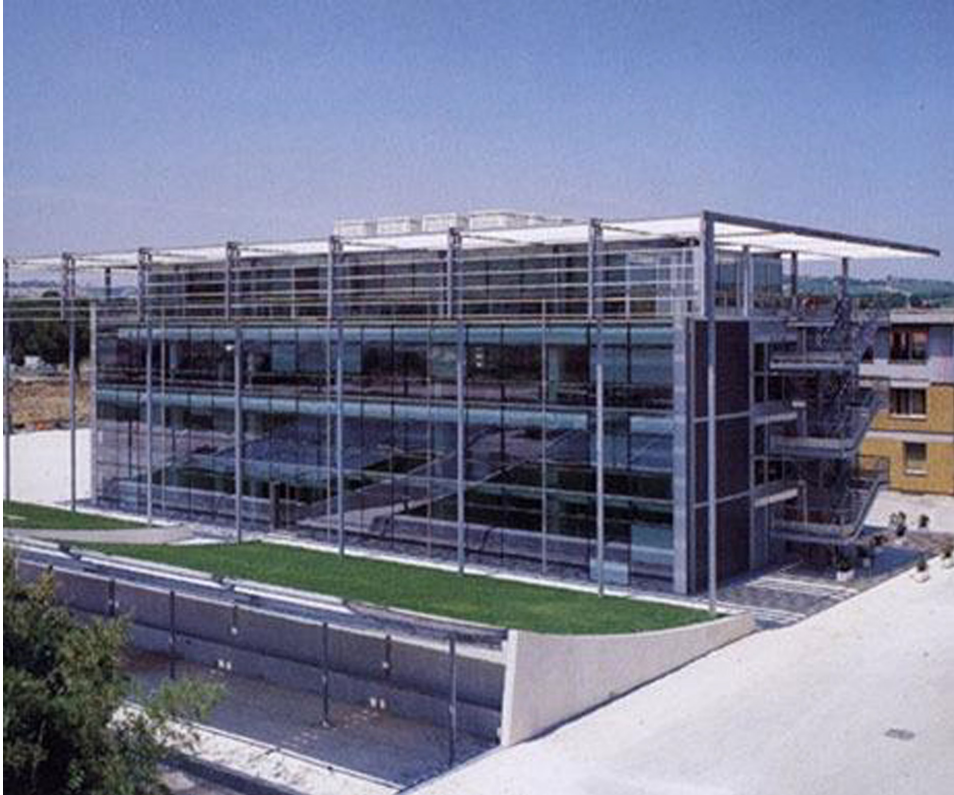
Figura 13b. Imágen Fachada soleada de la Sede central de iGuzzini en Recanati . Arq. Mario Cucinella – 2002
