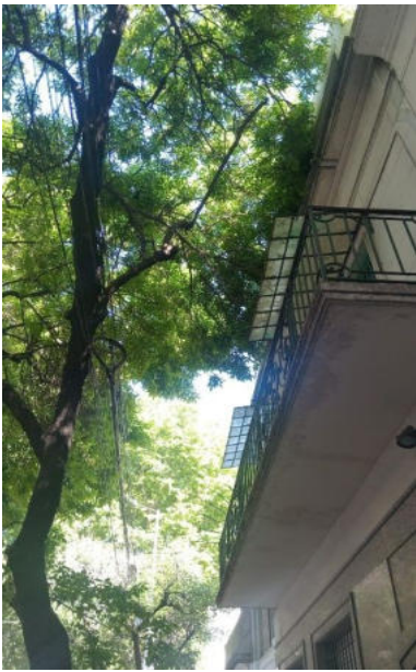
ANTES DESPEJE DE VENTANAS
