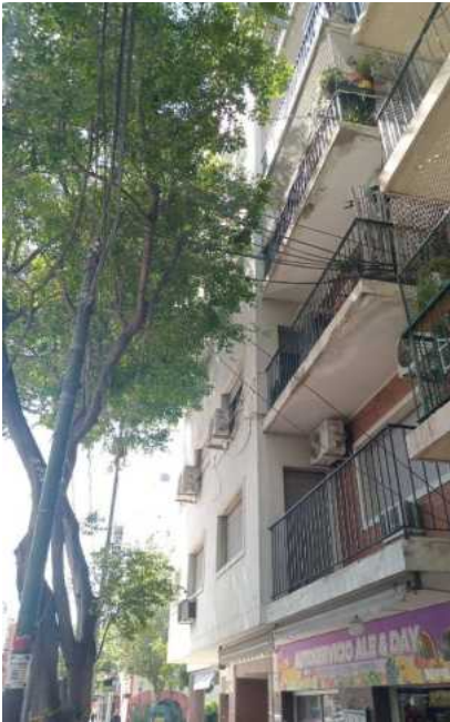
ANTES DESPEJE BALCON TERCER PISO
