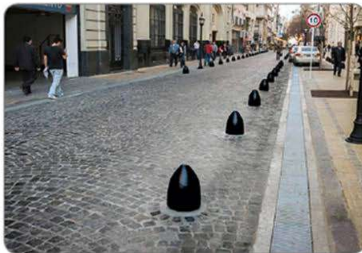
Adoquinado de granitullo en calle Bolívar
