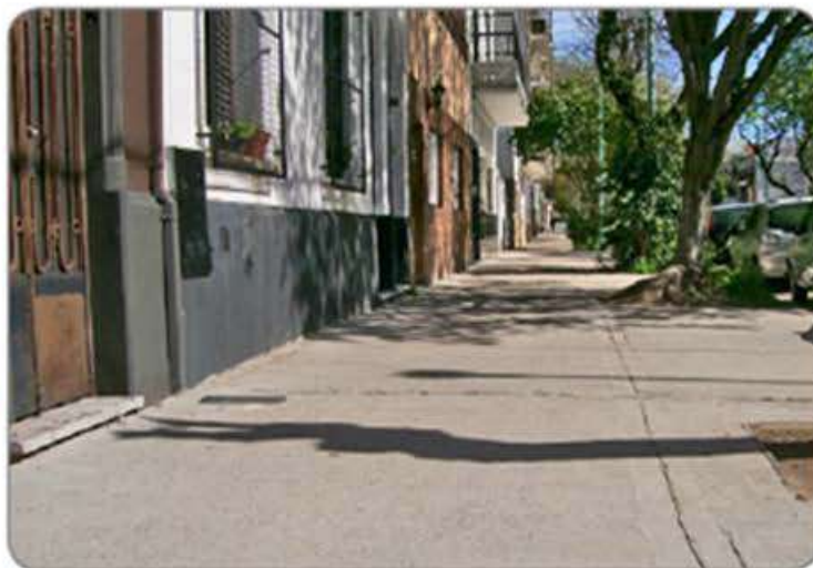
Hormigón en acera
