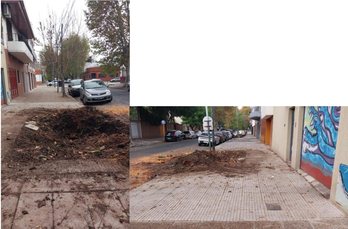
Imágenes 5 y 6: Vista de la plantera y vereda pos ext. Lado ascendente y lado descendente.
