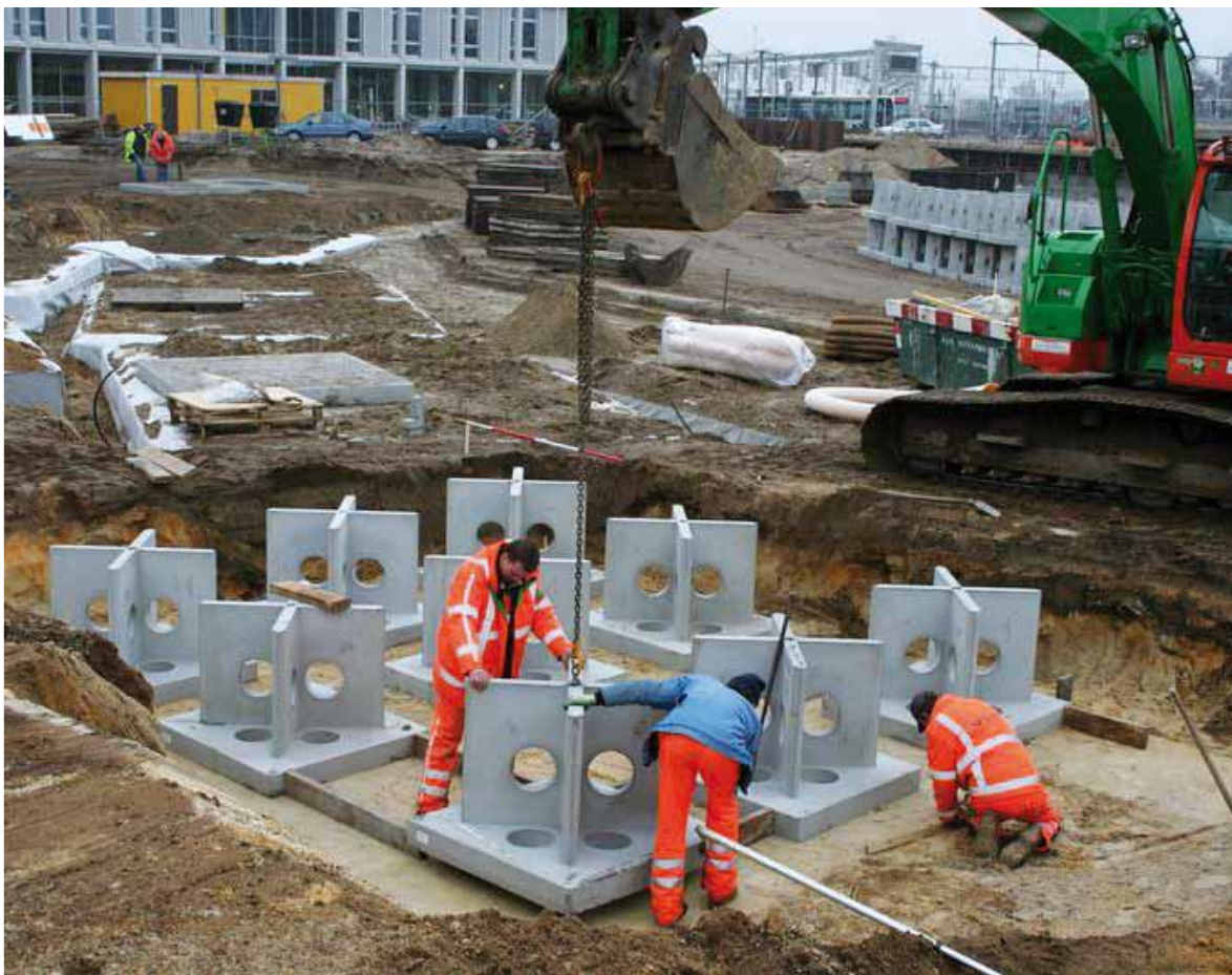
Instalación módulos sistema de Celdas
