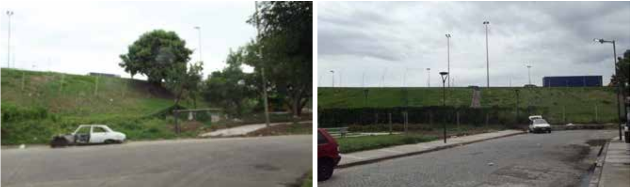
Imágenes 152 y 153: Izquierda, vista del terraplén de la Autopista 25 de Mayo lado sur. Derecha, vista del terraplén de la Autopista 25 de Mayo lado norte.
