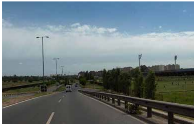
Imagen 142: Vista desde la Av. Castaños a la altura de la Autopista Pte. Héctor J. Cámpora (a la derecha campo de deportes del Club Deportivo Español).
