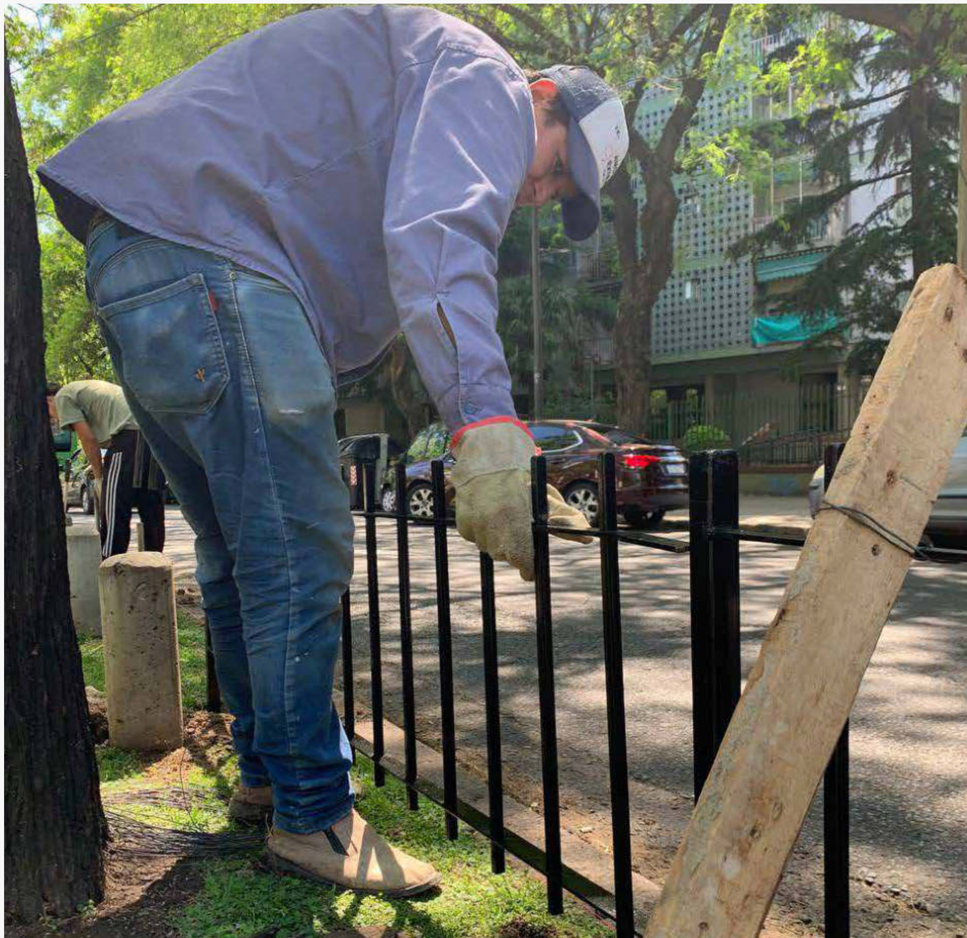
Mantenimiento perimetral (Canteros centrales de Av. Patricias Argentinas)
