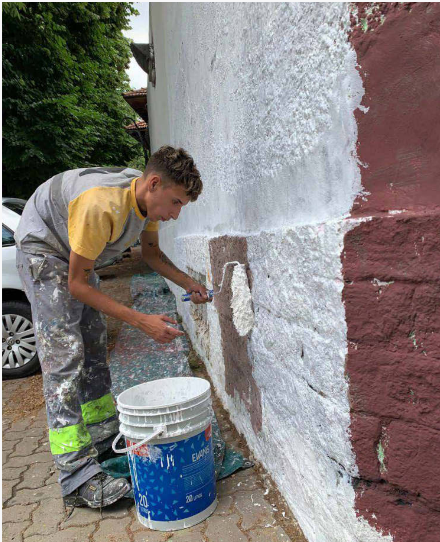
Trabajos de pintura (Hospital Pasteur)
