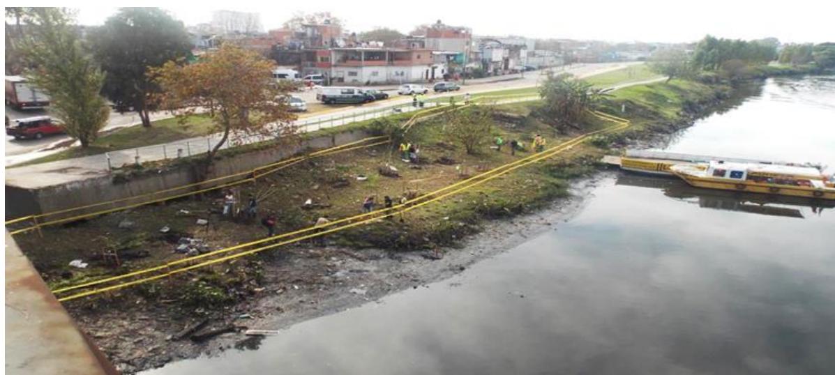
Trabajos de restauración ecológica en la costa del Riachuelo a la altura del Puente Ezequiel Demonty en abril de 2015.
