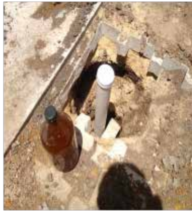
Terminación de tratamiento y obra de muestreo final
