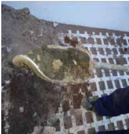
Ejecución de sondeo / tratamiento
