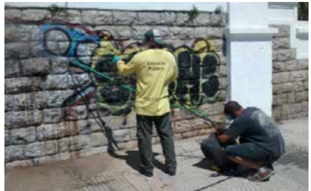
Desgrafitado de muros utilizando arenado por vía húmeda.
