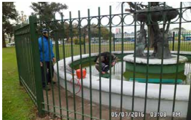
Trabajos en cañerías de impulsión.
