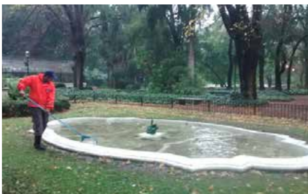
Trabajos en batea
