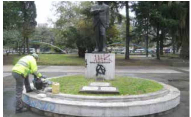
Desgrafitado de muros utilizando arenado por vía húmeda.
