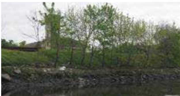
Punto 11: camino de sirga villa 26 lindante al puente Bosch.
