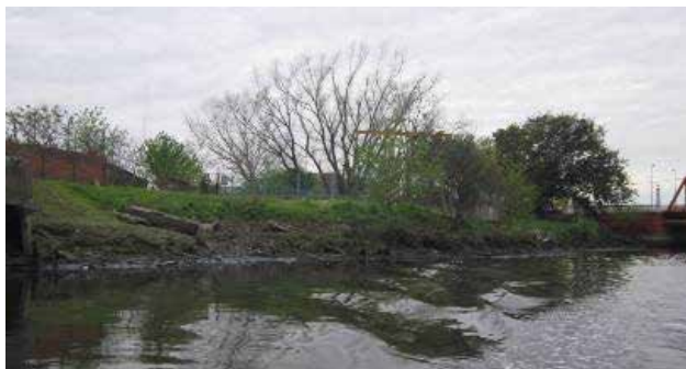
Punto 9: aguas abajo del puente Victorino de la Plaza.
